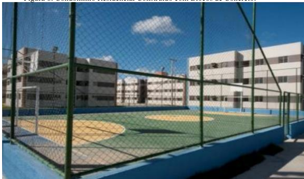
Figura 8: Condomínio Residencial Construído com Blocos de Concreto.
