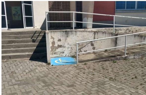
Figura 6 – Entrada com rampa de acesso ao prédio anexo
