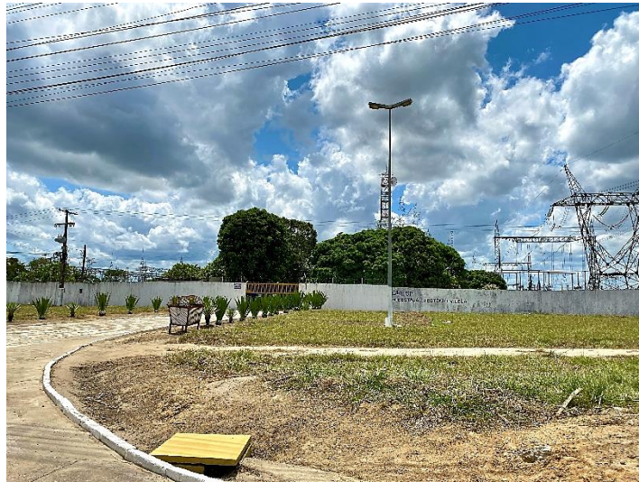
Figura 19. Área construída 1 - Central de distribuição de Energia da Companhia Hidrelétrica do São Francisco (Chesf).
