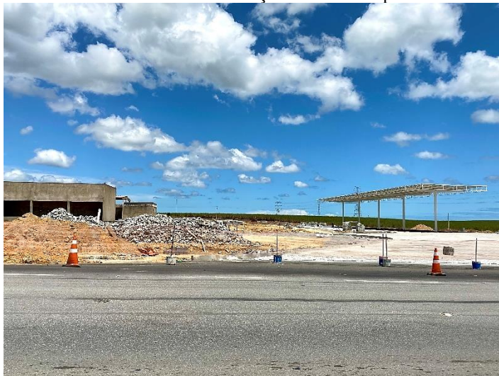
Figura 22. Área construída 4 – construção de um novo posto de combustível.
