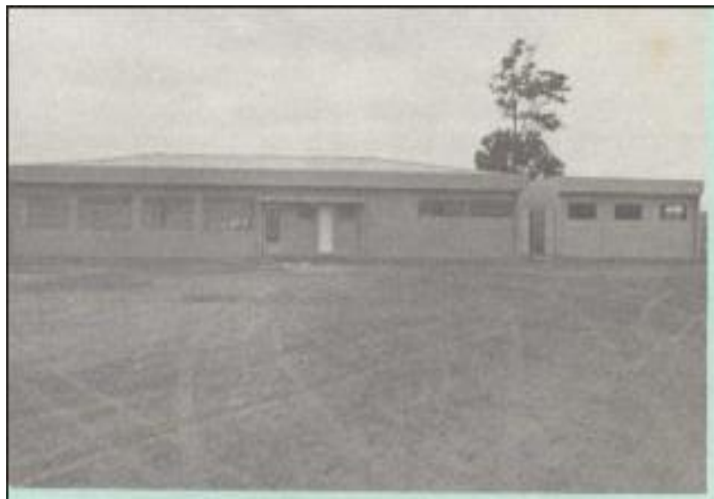
Figura 14 - Refeitório do EDESSA reformado
