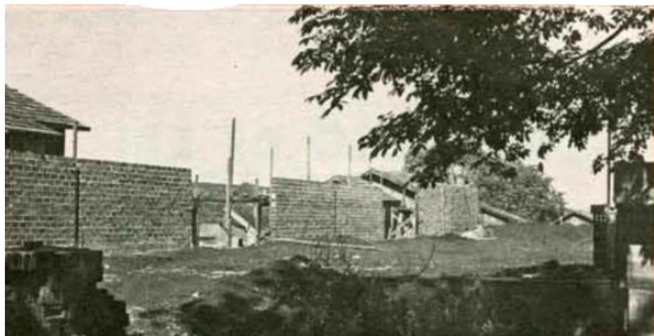
Figura 25 - Parque Industrial do IAP em construção
