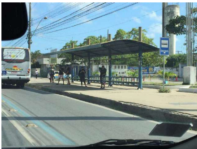
Figura 26 - Abrigo de ônibus na Av. Durval de Góes Monteiro
