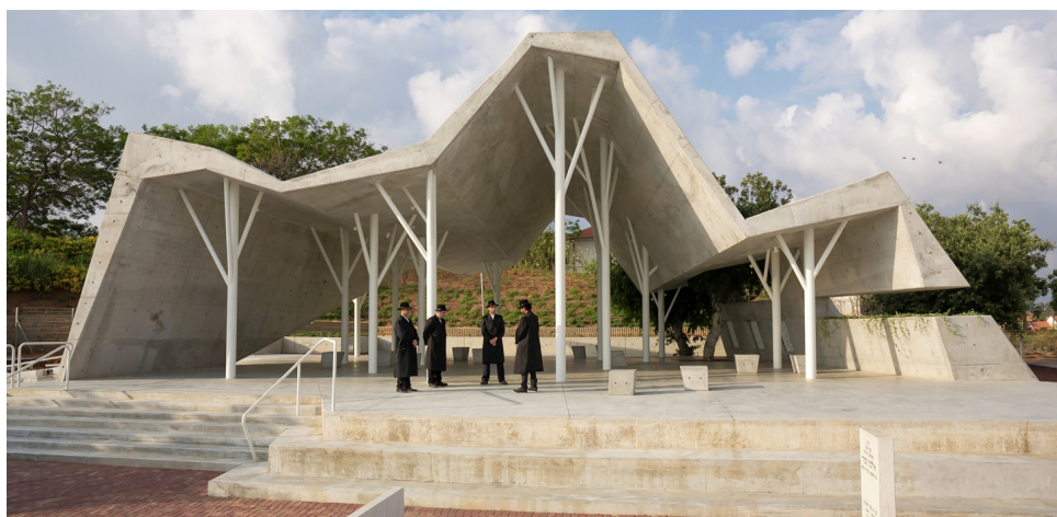
Figura 2.11 – Estrutura de concreto apoiada na de aço: Open-sided Shelter
