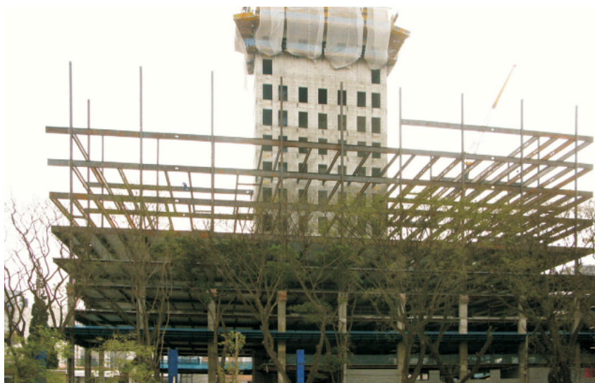
Figura 2.19 – Aberturas no núcleo de concreto
