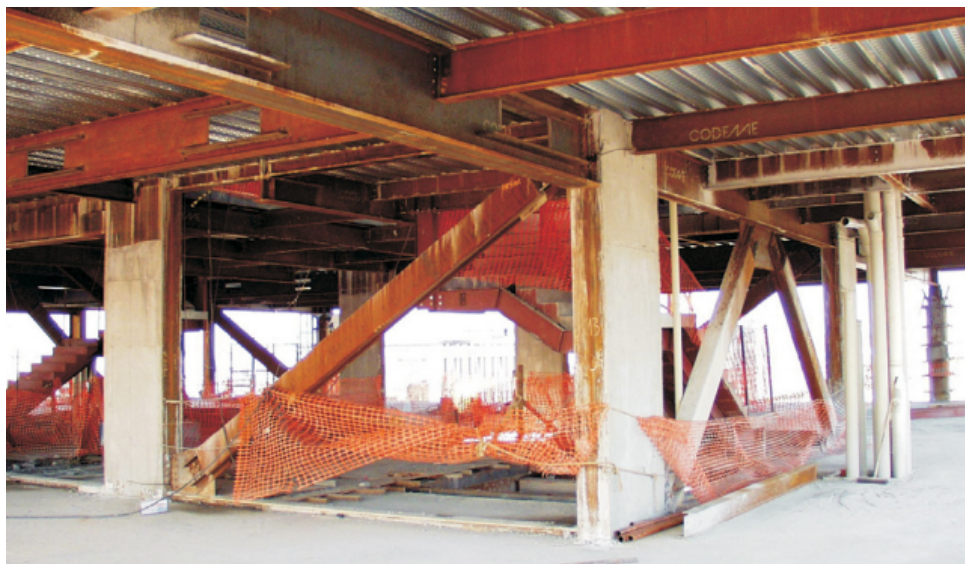
Figura 2.7 – Contraventamentos em torno da área de serviço
