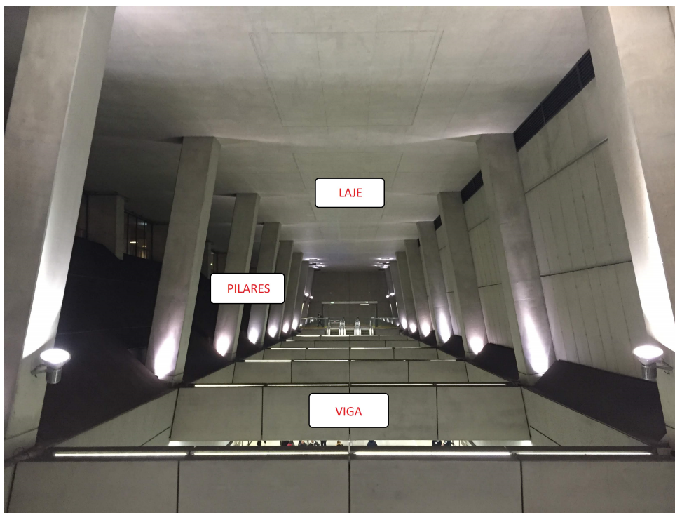
Figura 2 – Elementos estruturais em uma estação de metrô 2 .
