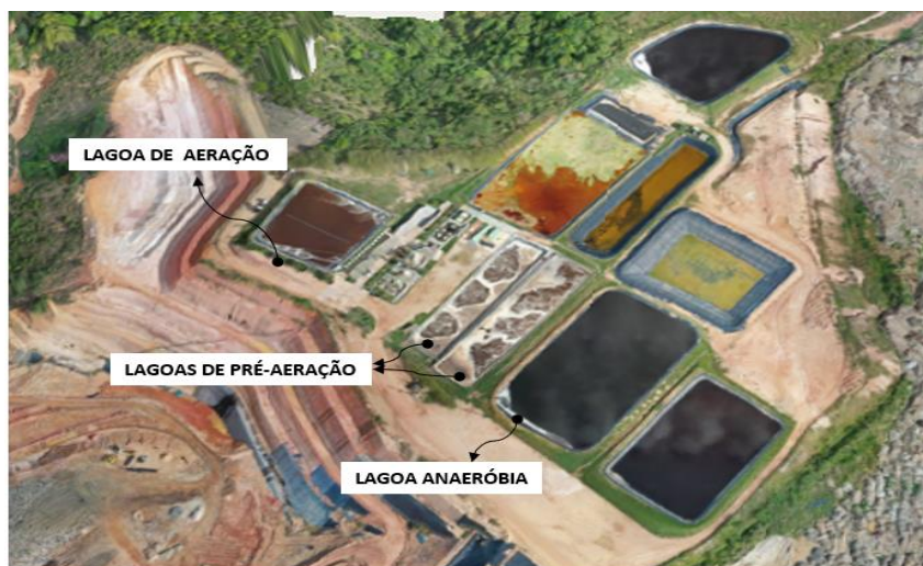
Figura 24: Localização das lagoas na estação de tratamento Fonte: Autora (2022)
