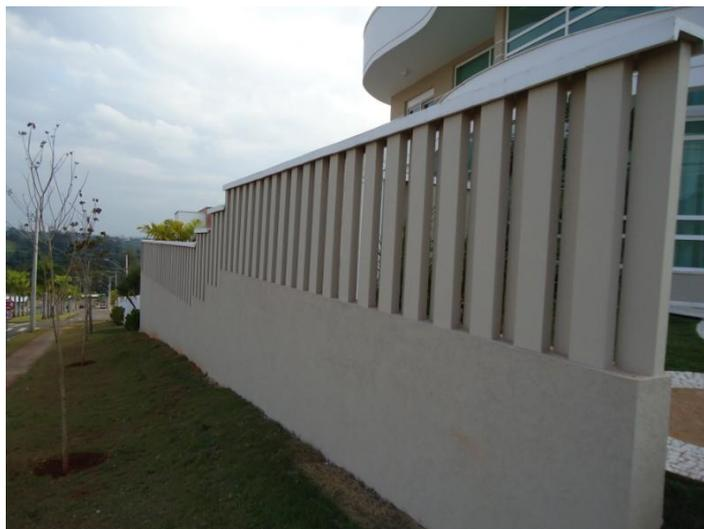
**Figura 28 -Fachada em alvenaria com brise vertical**
