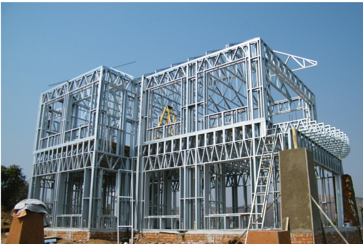
Figura 1 : Obra executada em Light Steel Frame
