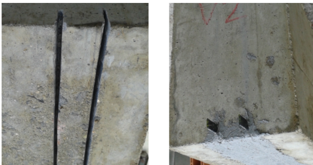
Figura 11: Entalhes no cobrimento de viga e laminados de CFRP inseridos
