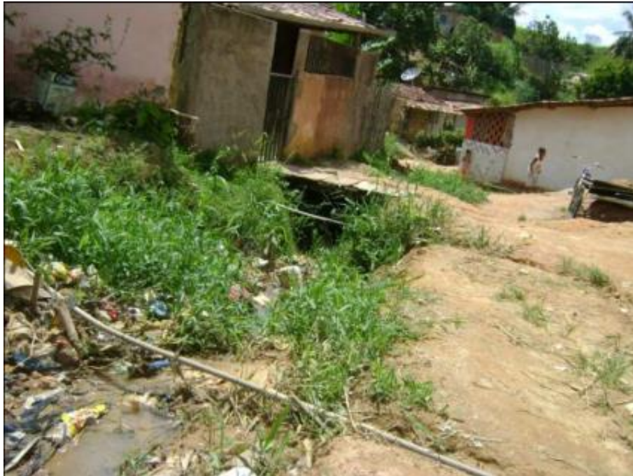
Figura 3: Esgoto a céu aberto perigosamente perto de ligações de água no Benedito Bentes
