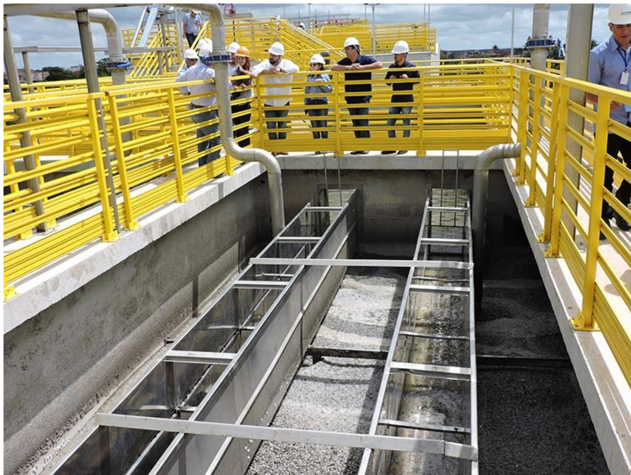
Figura 13: Um dos reatores da ETE Benedito Bentes, com biomédias à mostra
