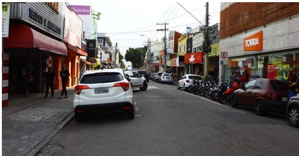
Figura 23: Trecho da Rua Coronel José Monteiro antes da requalificação.
