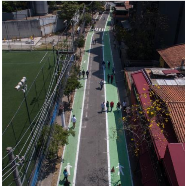
Figura 22: Trecho da Rua Joel Carlos Borges após a intervenção.
