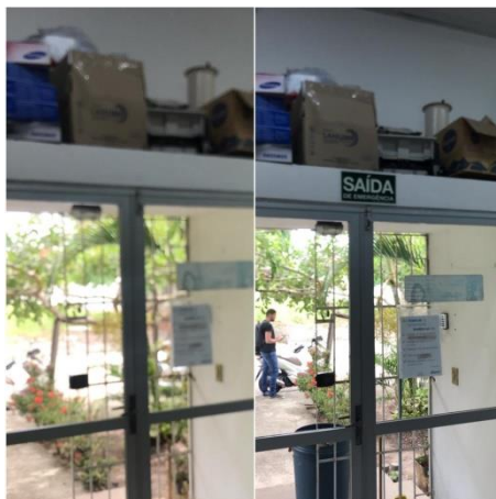
Figura 7. Instalação Sinalização Saída de Emergência (Salão Principal).
