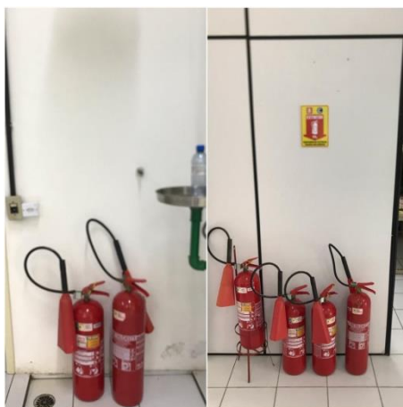
Figura 8. Realocação e Instalação Placa Equipamentos – Extintores (Salão Principal).
