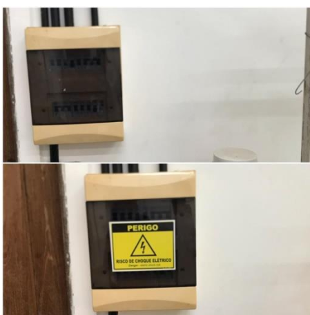
Figura 14. Instalação Sinalização de Alerta (Salão 2).
