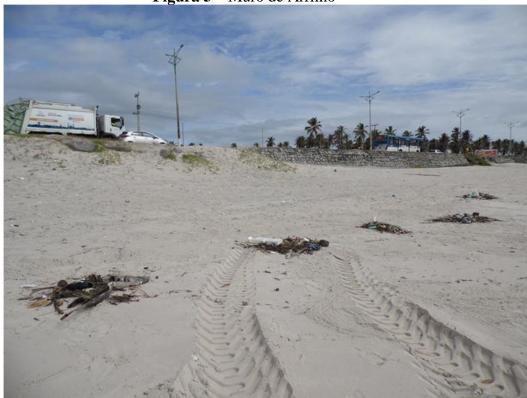
Figura 5 – Muro de Arrimo
