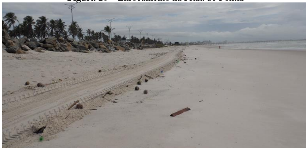
Figura 10 – Enrocamento na Praia do Pontal
