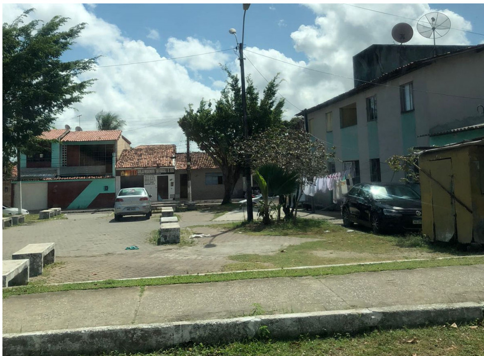
Figura 36 – Atual situação do conjunto.
