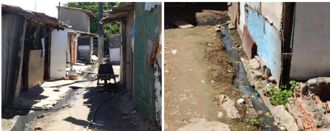
Figura 13 – Esgoto correndo a céu aberto era um dos grandes problemas da antiga Comunidade.
