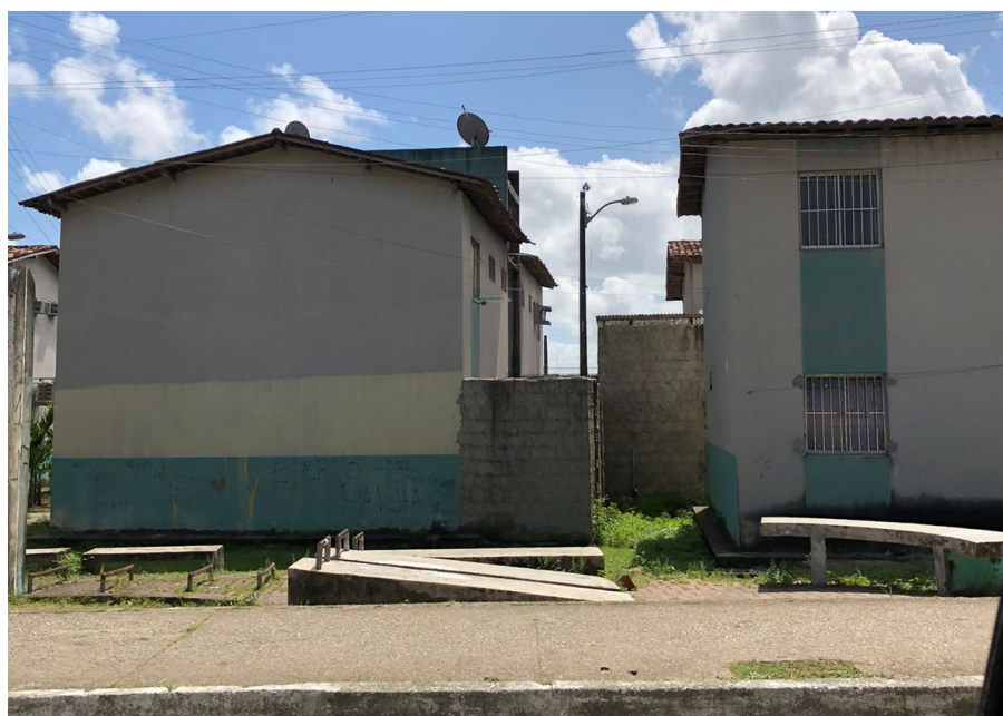
Figura 35 – Atual situação do Conjunto.
