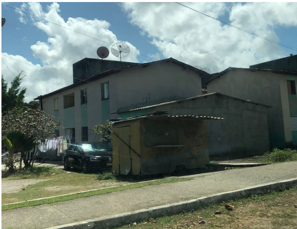
Figura 37 – Atual situação do conjunto.
