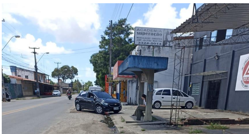
FIGURA 21. PONTO DE ÔNIBUS COM ANTIGA ESTRUTURA
