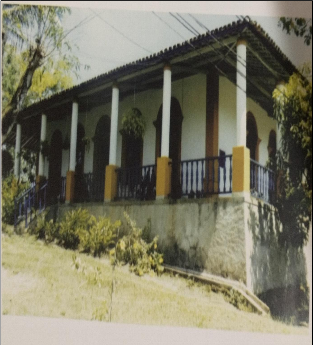
Figura 3 – Pilar: Casa-Grande Do Engenho Terra Nova.
