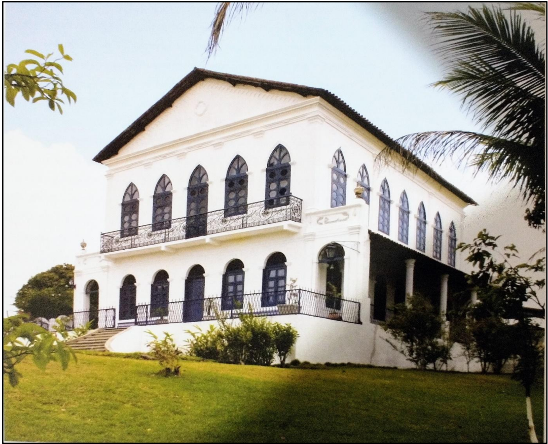
Figura 2 - Casa-Grande do Engenho Bananal Fernandes – Viçosa, AL.
