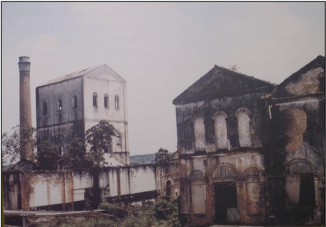
Figura 26 - Ruínas do Engenho Central Utinga Leão Rio Largo.
