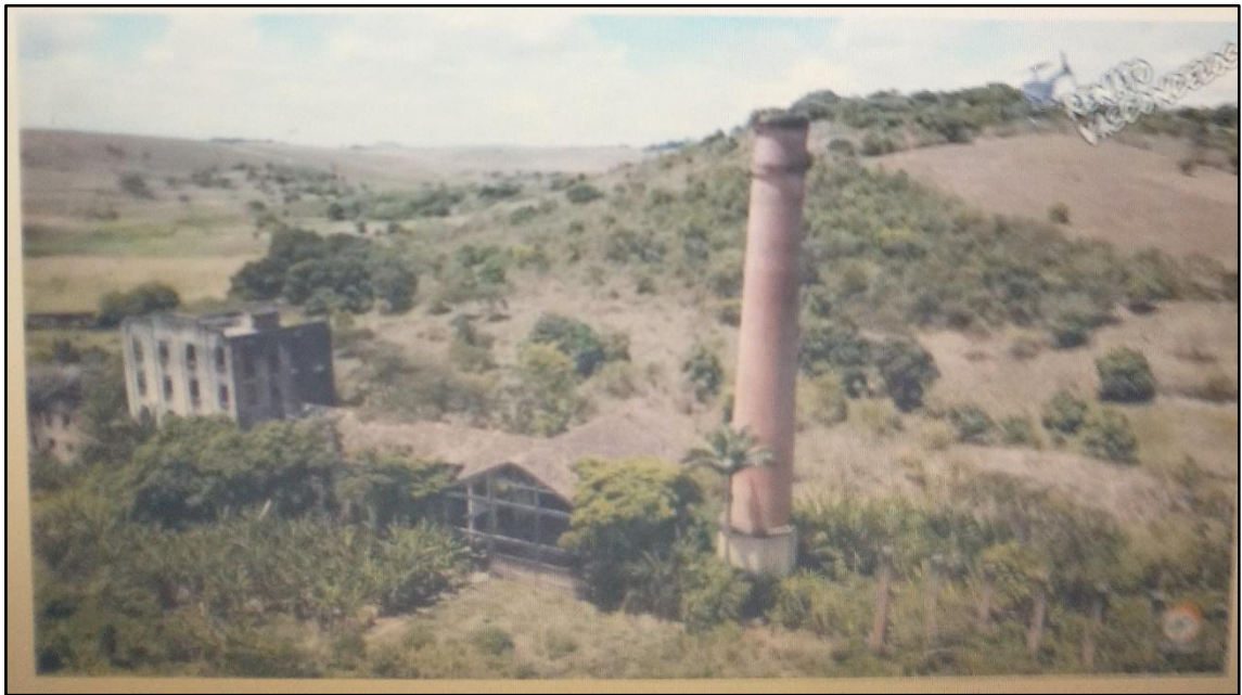
Figura 25 - Alagoas: Usina Brasileiro: Ruínas da Usina Brasileiro.
