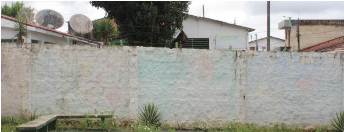
Figura 3 - Muro a ser pintado
