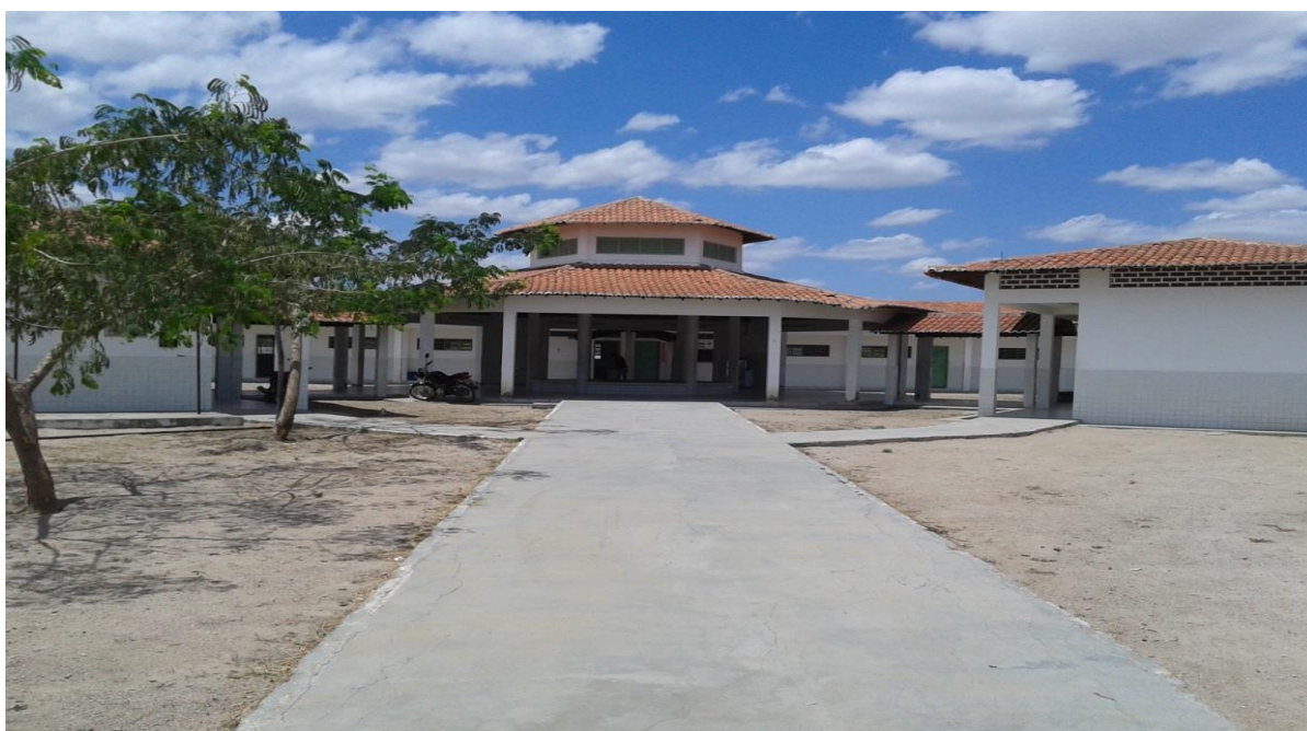
Figura 2 – Entrada da escola e pátio central
