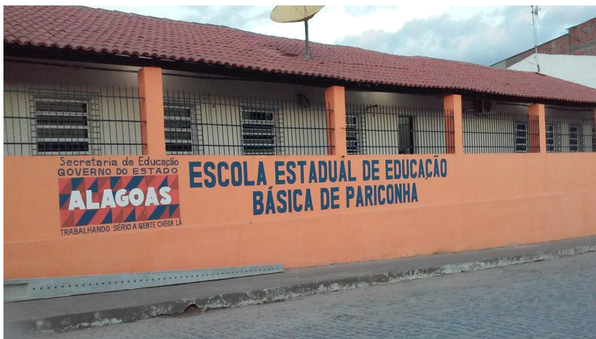
Figura 7 – Fachada lateral da escola
