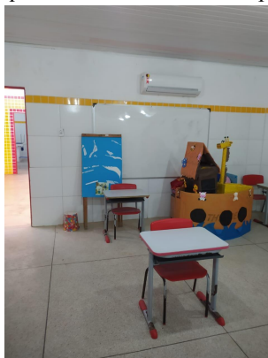
Figura 41: Sala de aula com quadro e ar-condicionados posicionados próximo à porta.
