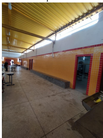
Figura 38: Abertura lateral na cobertura para entrada de luz no pátio da instituição.
