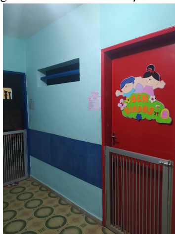
Figura 70: Vão com tubulação central.
