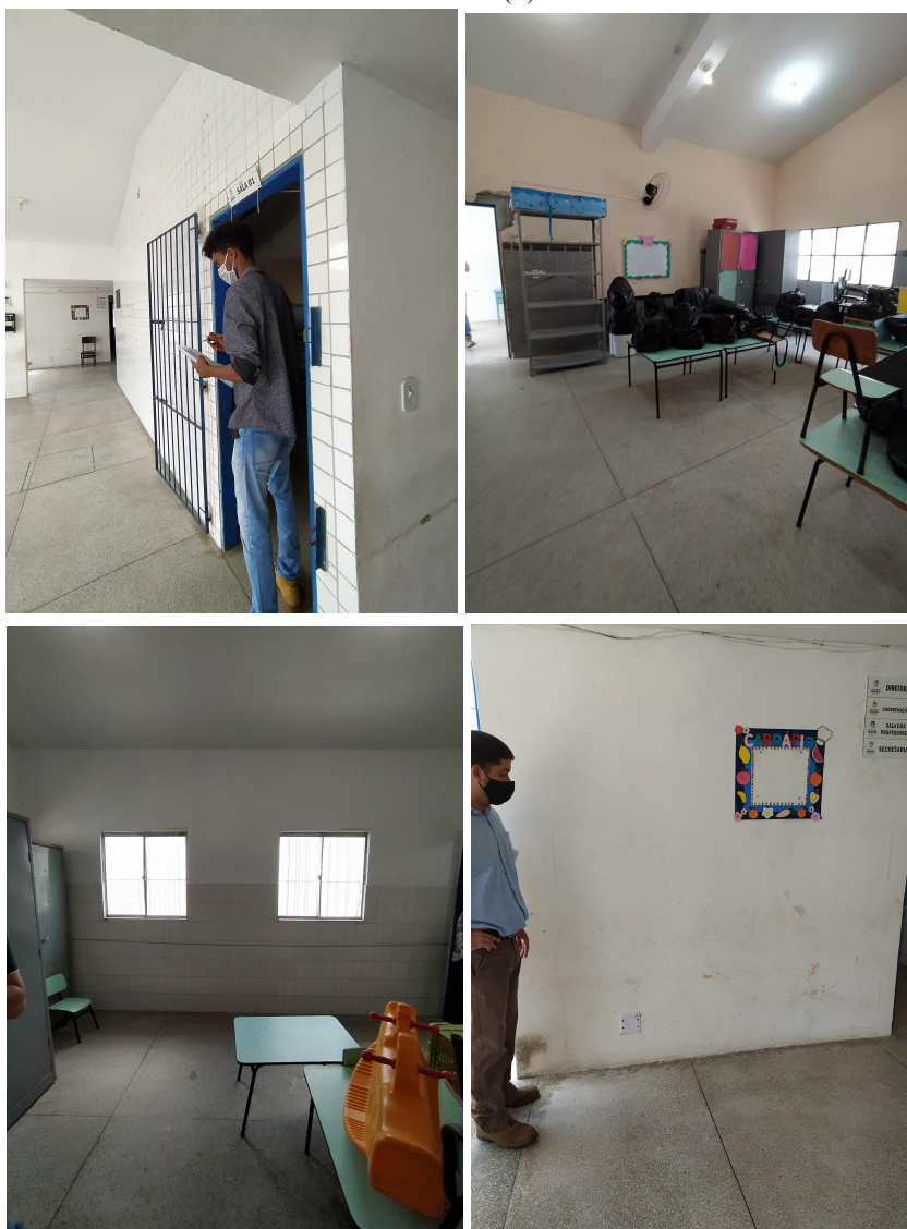
Figura 22: Ambientes da Escola C. Pátio da escola (a), sala de aula (b), sala de aula (c) e parede dos lavatórios (d).
