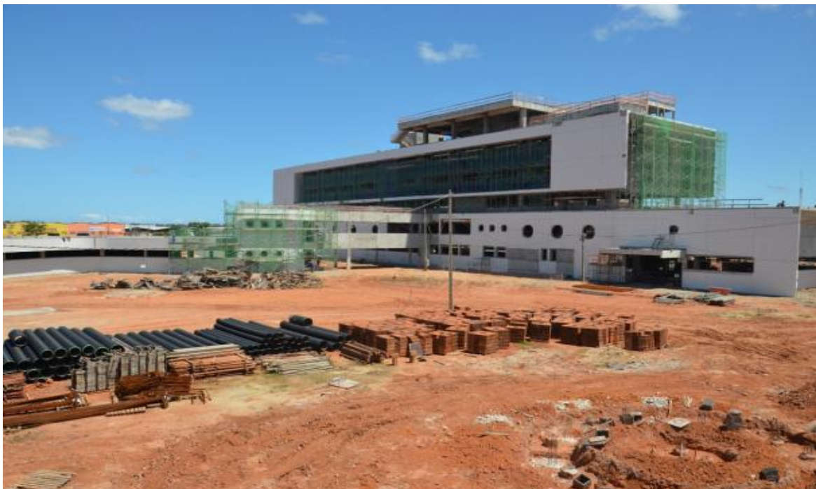
Figura 31- Hospital Metropolitano de Maceió
