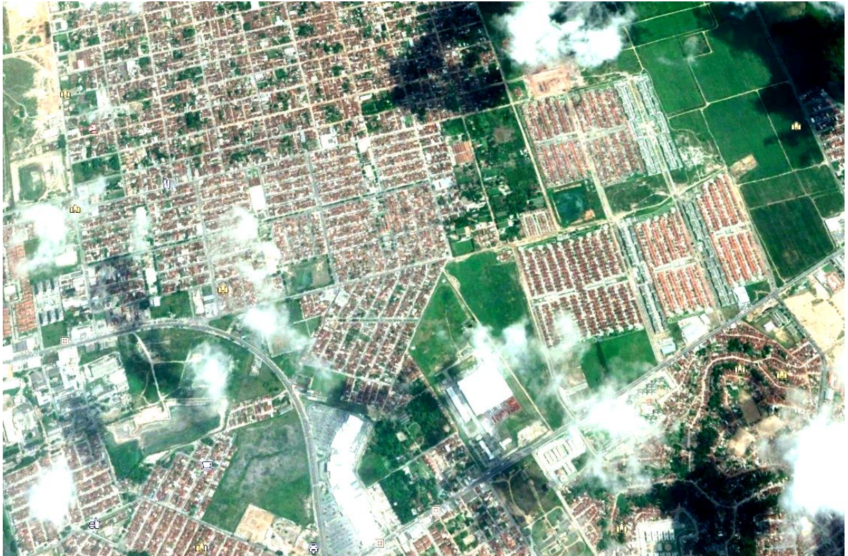
Figura 26- Conjunto Graciliano Ramos com sua pavimentação finalizada.
