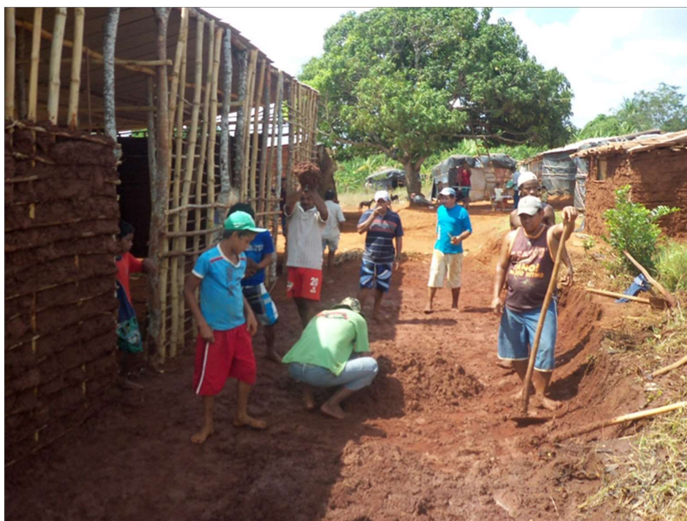
Imagem 2: Construção da Casa de Resistência: Maninha Xukuru-Kariri, no lado esquerdo é possível observar uma das paredes da edificação, parte estando já preenchida com barro e o restante estando formado apenas pela estrutura de madeira. Ao lado da estrutura é possível observar homens e crianças que estão preparando o barro para continuar o trabalho de preenchimento das paredes. Foto Disponibilizada pelo missionário do CIMI Zennus Diny.
