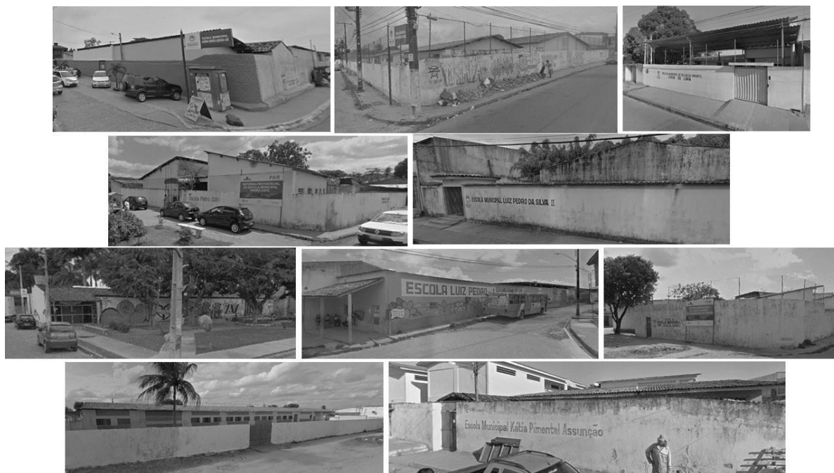
Figura 3127 - Fachada das escolas com muros opacos
