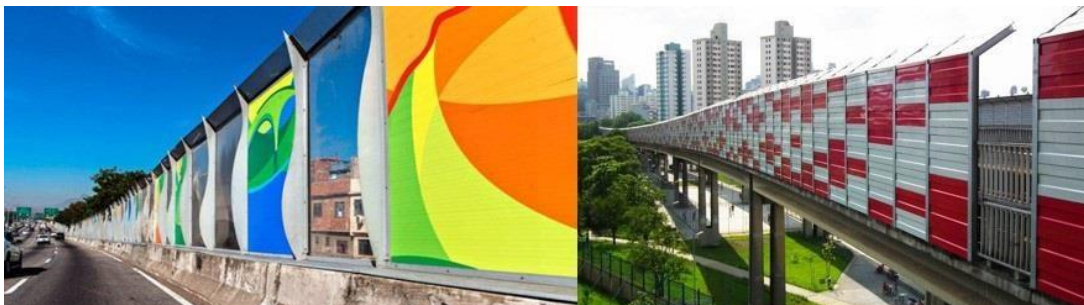
Figura 13 - Exemplos de barreiras acústicas nas cidades do Rio de Janeiro e São Paulo
