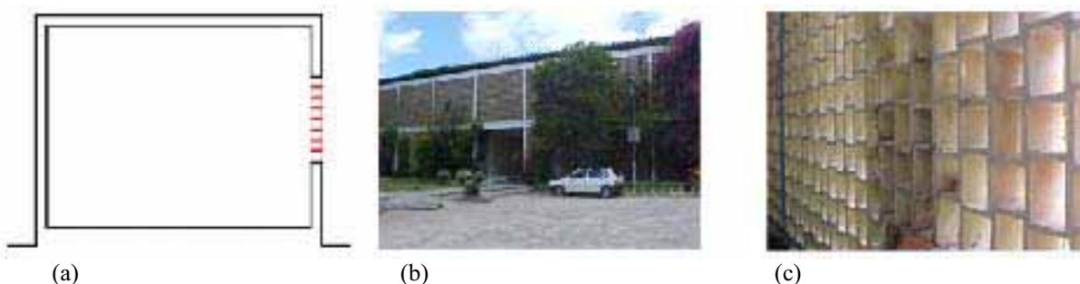
**Figura 21: Corte esquemático (a) e exemplo de elemento vazado no Prédio de Física da UFAL, vista externa (b) e vista interna (c).**
