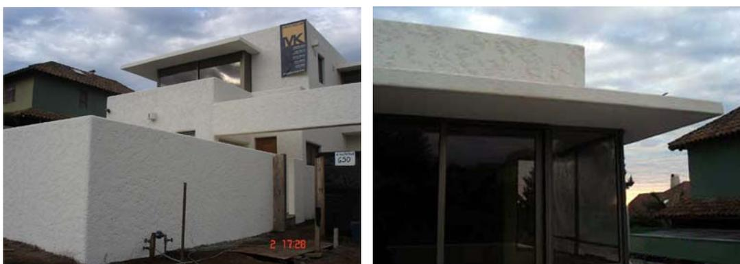
**Figura 1-17 – O Beiral: uma proteção solar para uma “Janela em Sacada”.**
