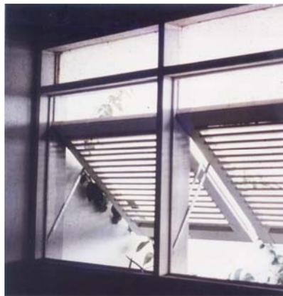
**Foto 6 – Janela maxim-ár dotada de venezianas podem auxiliar na ventilação e iluminação natural dos ambientes.**
