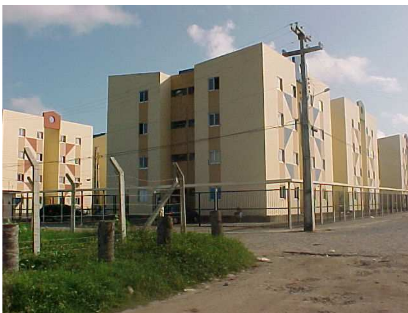
Figura 3.3 – Objeto de Estudo - Residencial Canto dos Pássaros - Vista externa a partir do Nordeste, onde se observa que não sofre obstrução de elementos externos
