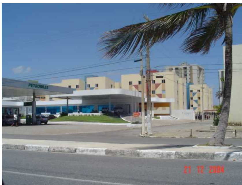
Figura 3.4 – Objeto de Estudo - Residencial Canto dos Pássaros - Vista externa a partir do Sudeste, onde se observa que não sofre obstrução de elementos externos
