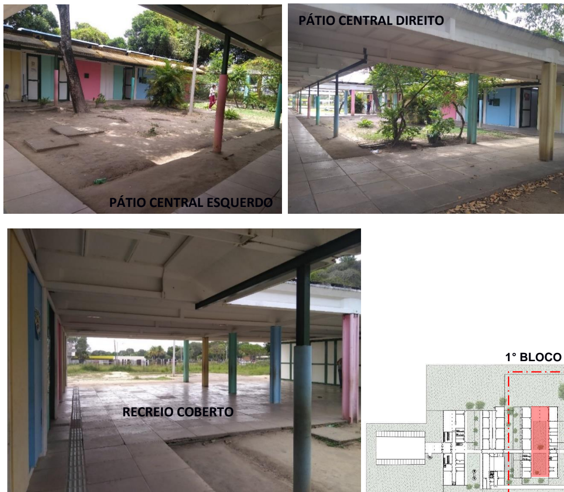
Figura 119: Vista para os dois pátios abertos e para o recreio coberto, respectivamente.
