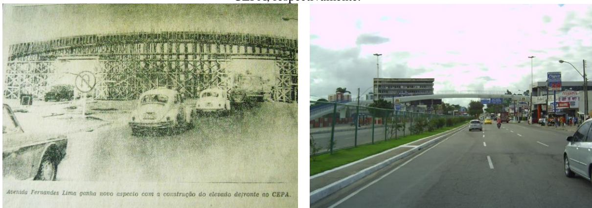
Figura 41 - Imagem da construção da passarela em frente ao CEPA em 1974 e Imagem da passarela atual do CEPA, respectivamente.
