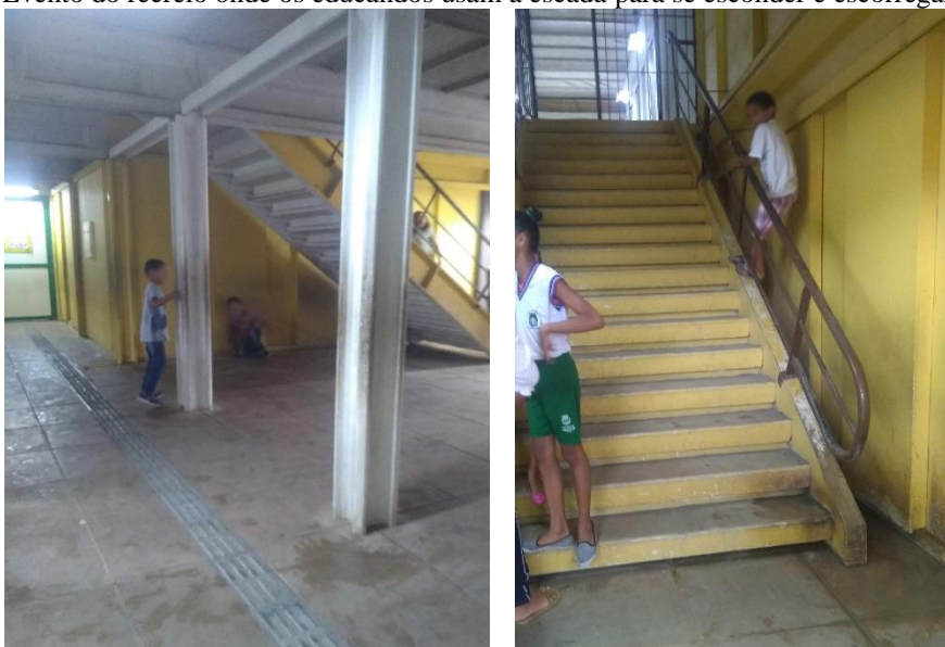
Figura 141: Evento do recreio onde os educandos usam a escada para se esconder e escorregar no corrimão
