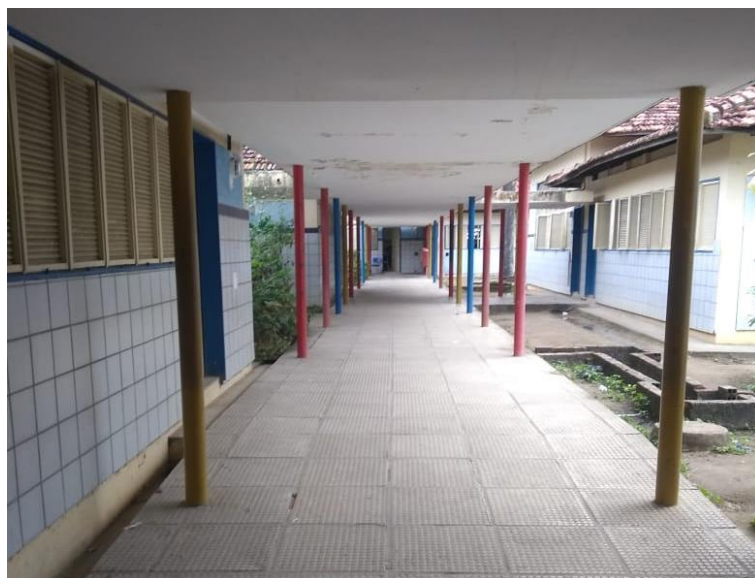
Figura 79: Corredor do lado esquerdo da escola.
