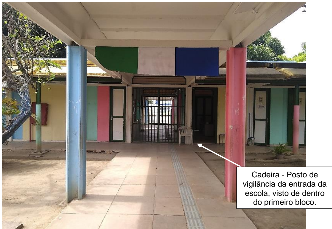
Figura 118: Circulação entre os dois pátios abertos do primeiro bloco com visão para a porta de acesso à escola com a cadeira do funcionário ao lado.
