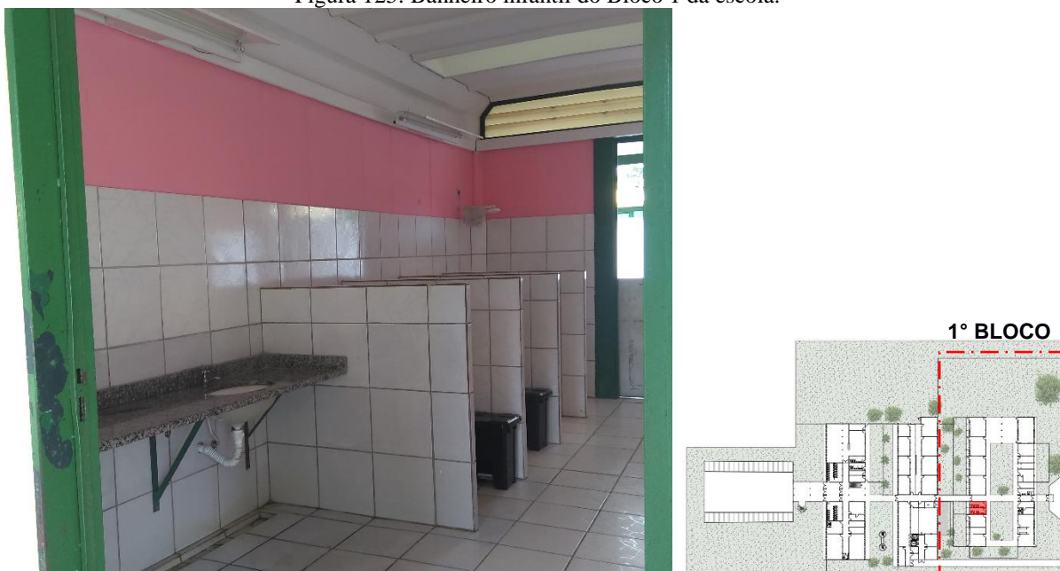
Figura 125: Banheiro infantil do Bloco 1 da escola.
