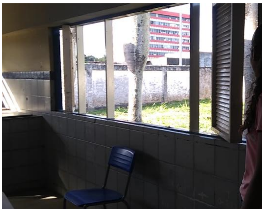
Figura 104: Janelas de sala de aula quebradas e arrancadas.
