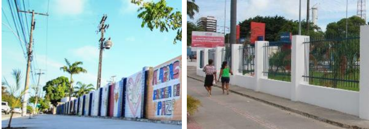
Figura 49 - Antes e depois do muro do CEPA após a reforma.
