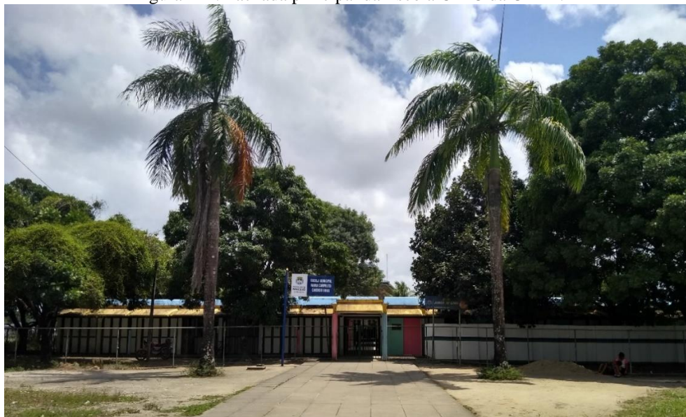
Figura 112: Fachada principal da Escola CAIC da UFAL.
