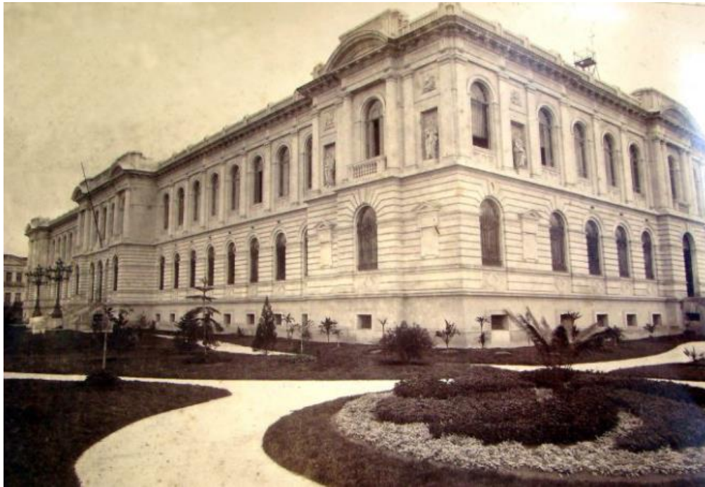
Figura 2 - Fachada da Escola Normal da Capital de São Paulo.
