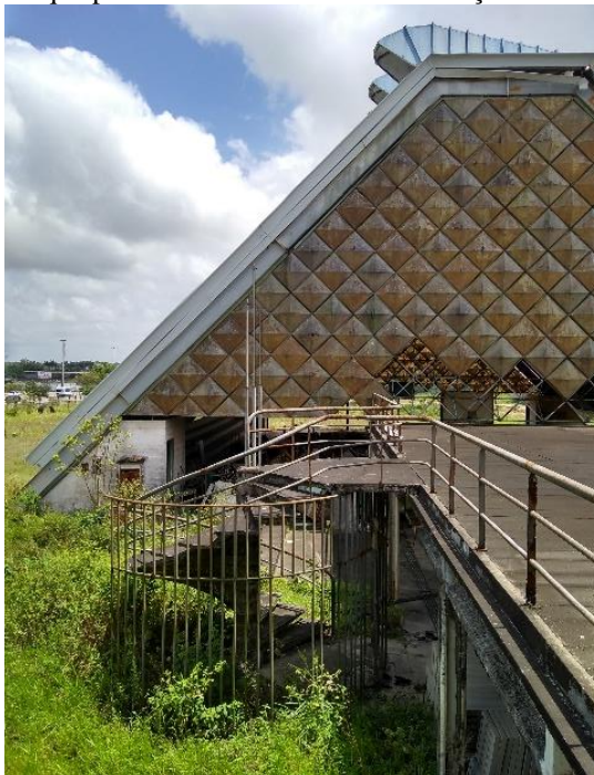
Figura 159: Destaque para a escada helicoidal do terraço coberto pela vegetação
