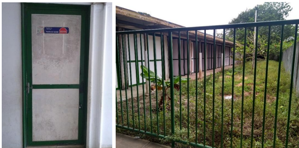
Figura 132: Entrada de fechada e vista para as salas do posto de saúde.
