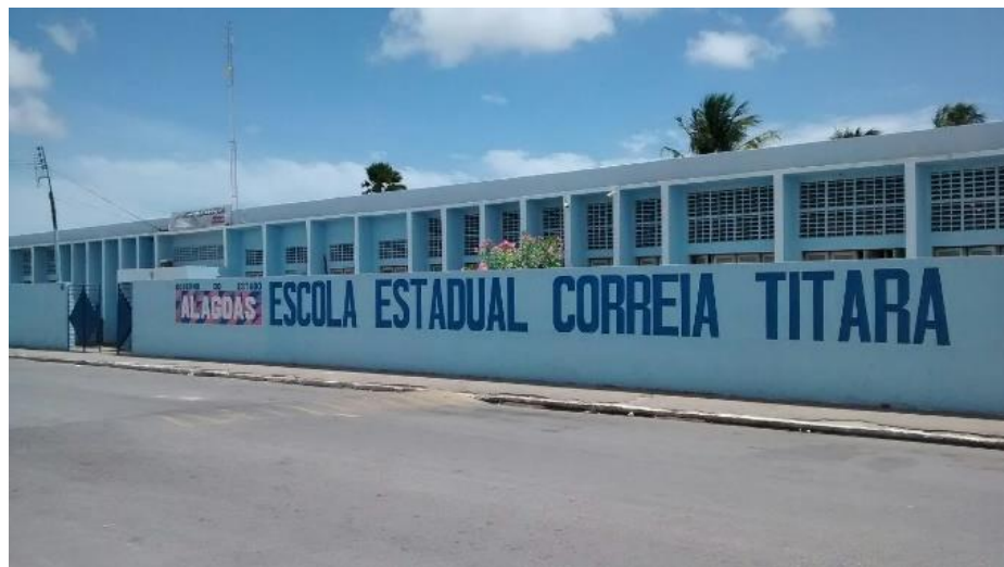
Figura 38: Fachada da atual Escola Estadual Correia Titara.
