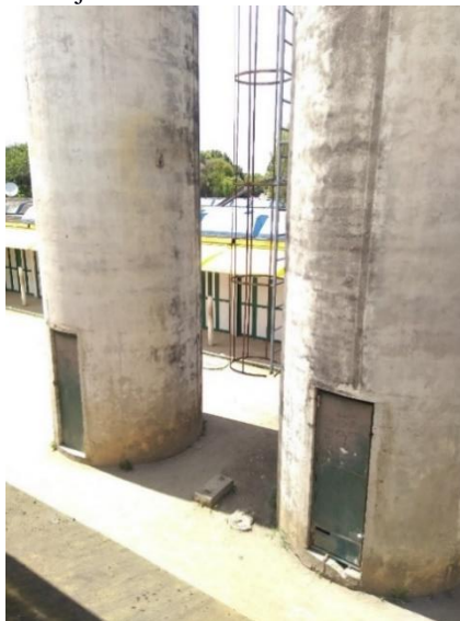
Figura 164: Vista da janela de uma das salas de aula do terceiro bloco
