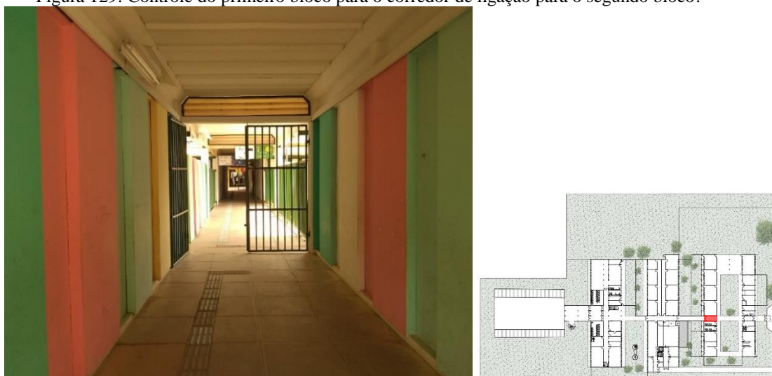
Figura 129: Controle do primeiro bloco para o corredor de ligação para o segundo bloco.
