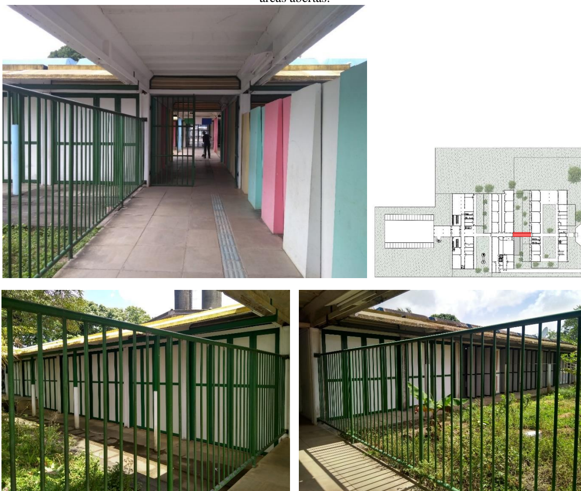
Figura 130: Corredor de ligação entre o primeiro e o segundo bloco delimitado por muro e grade, com vista para áreas abertas.
