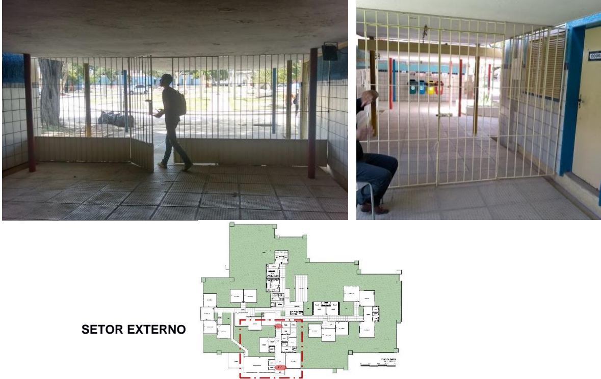
Figura 60 - Controle de acesso externo e controle de acesso interno, respectivamente.
