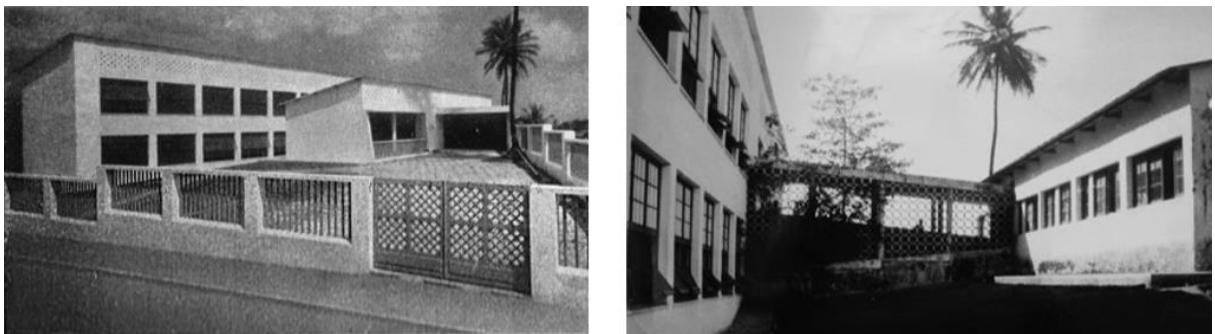
Figura 9 - Escola Classe 1 / Centro Educacional Carneiro Ribeiro, projetada por Diógenes Rebouças (1948-1950).
