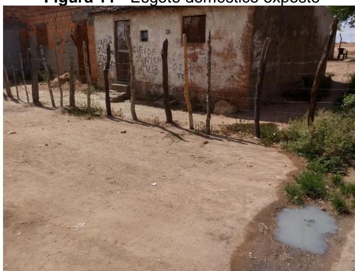
Figura 11 - Esgoto doméstico exposto
