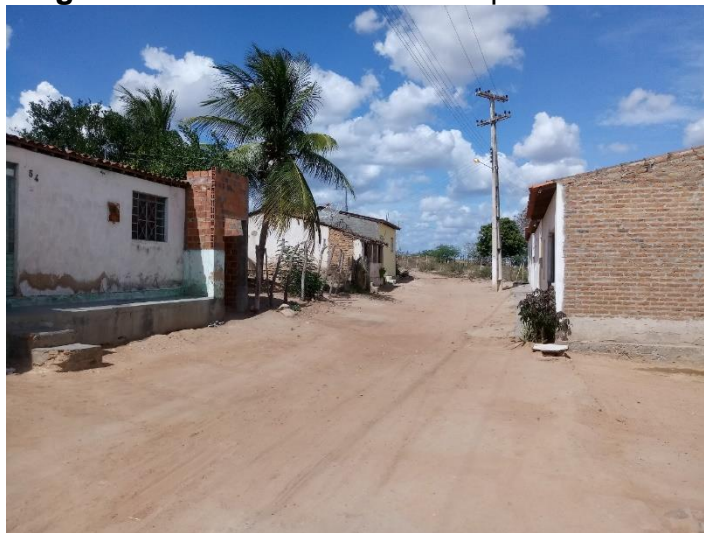
Figura 7 - Vista da saída da rua para a AL-220
