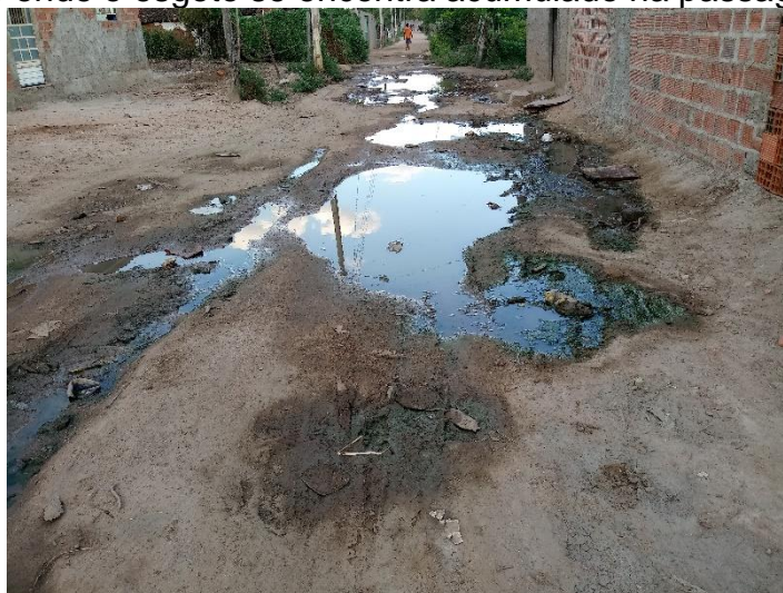
Figura 3 - Ponto onde o esgoto se encontra acumulado na passagem de pedestres
