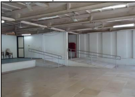
Figura 4.77 – Rampas de acesso ao auditório
