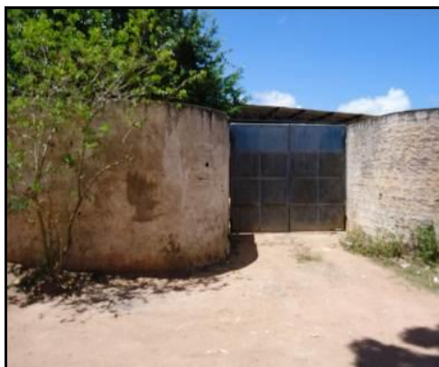
Figura 4.22 – Acesso de serviço
