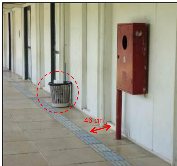
Figura 4.54 – Hidrante suspenso
