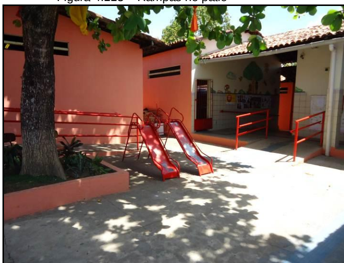
Figura 4.113 – Rampas no pátio
