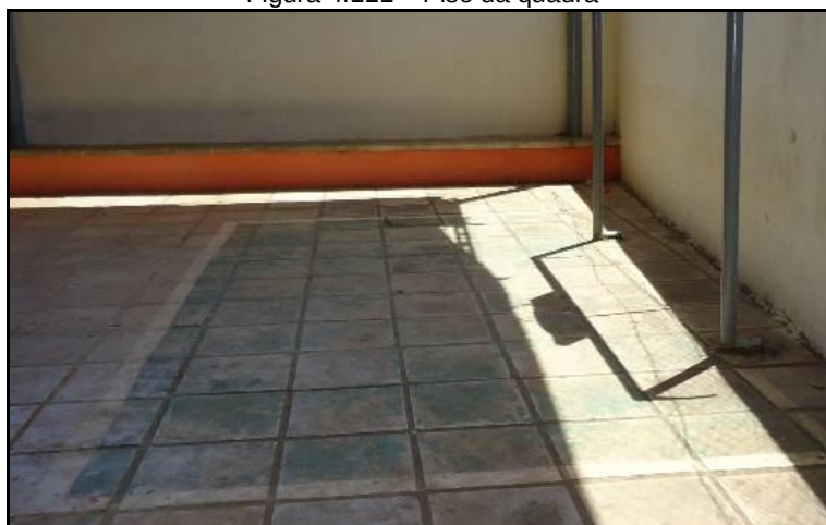
Figura 4.111 – Piso da quadra
