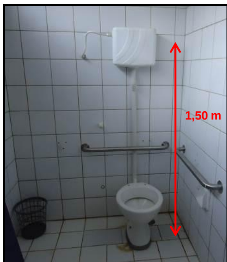
Figura 4.38 – Altura acionamento da descarga
