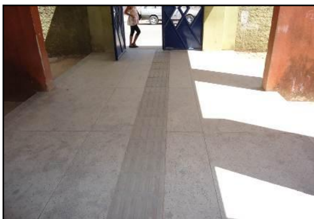
Figura 4.5 – Piso tátil no acesso a escola
