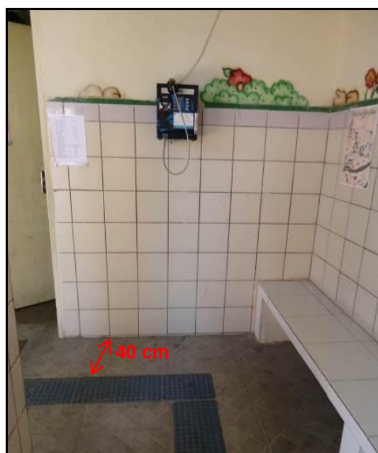
Figura 4.94 – Piso tátil na rampa
