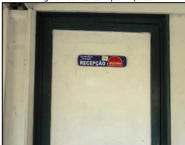
Figura 4.50 – Sinalização na porta.
