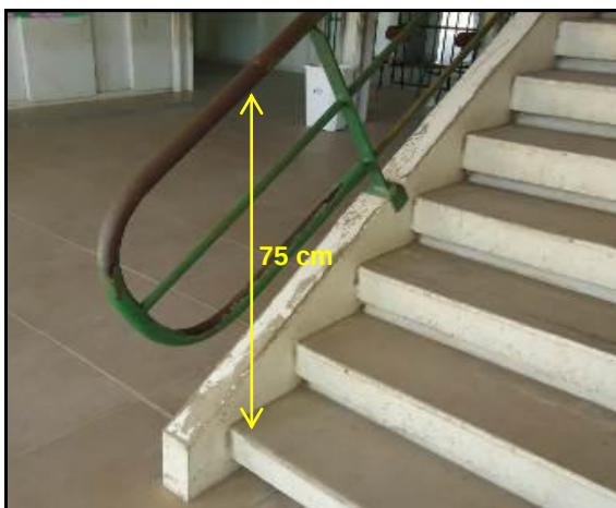
Figura 4.79 – Corrimão na escada
