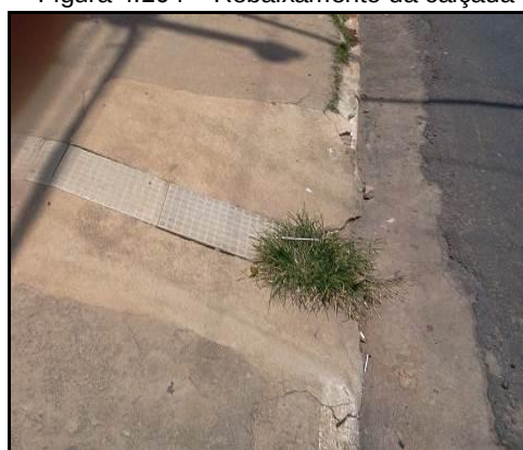
Figura 4.104 – Rebaixamento da calçada
