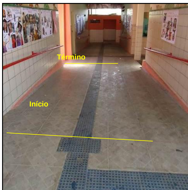
Figura 4.93 – Piso tátil na rampa
