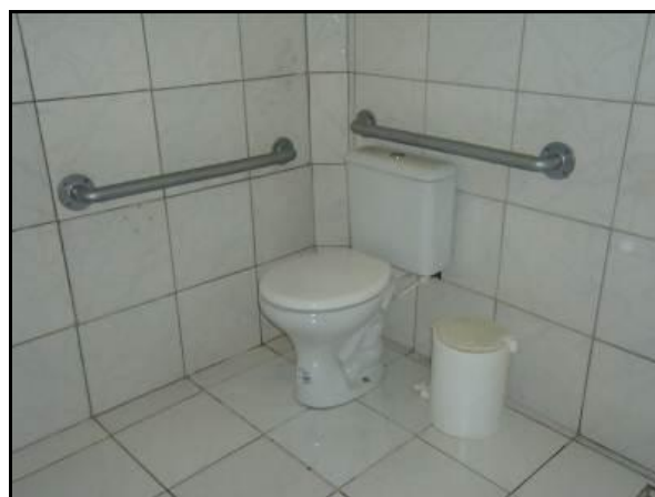
Figura 4.85 – Barra de apoio do vaso sanitário
