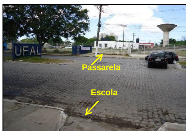
Figura 4.70 – Acesso à passarela
