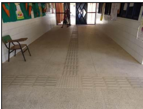
Figura 4.7 – Piso tátil na recepção
