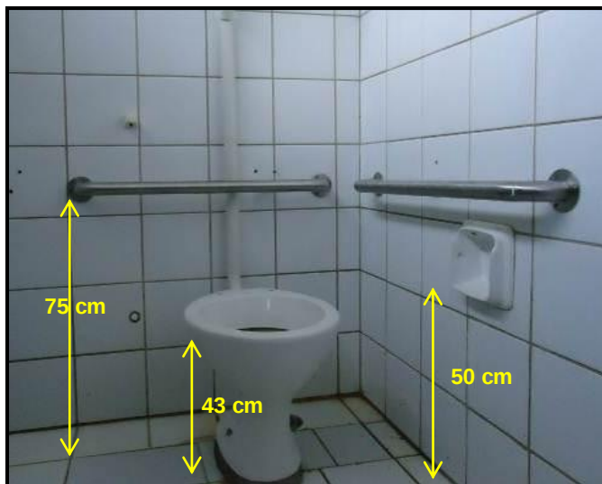
Figura 4.39 – Altura das barras de apoio e vaso sanitário
