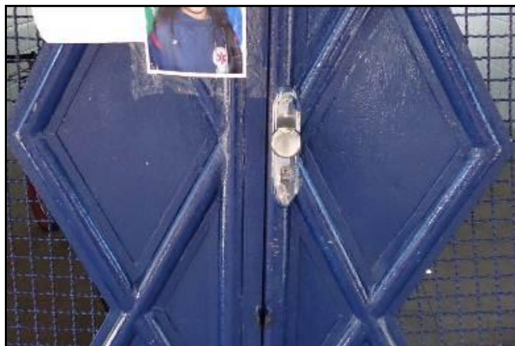
Figura 4.30 – Maçaneta do portão de acesso
