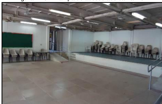
Figura 4.78 – Rampa de acesso aos camarins
