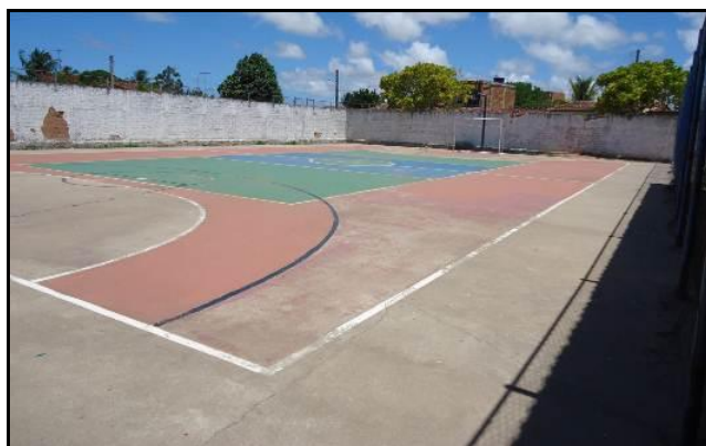
Figura 4.29 – Piso da quadra de esportes
