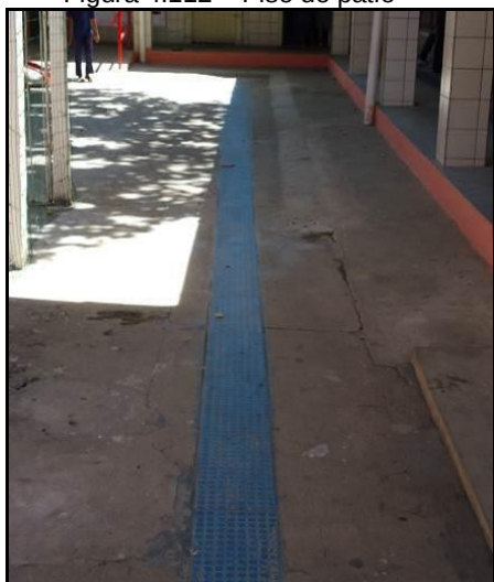
Figura 4.112 – Piso do pátio
