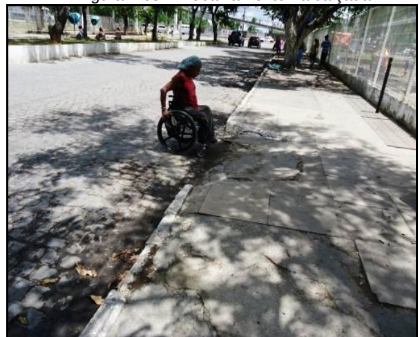
Figura 4.68 – Rebaixamento na calçada
