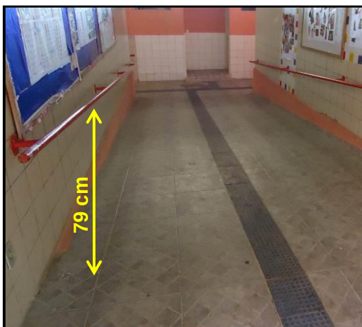
Figura 4.115 – Corrimão da rampa
