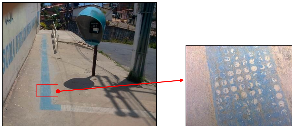
Figura 4.90 – Piso tátil na calçada
