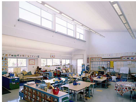
Figura 09: Iluminação zenital tipo monitor.
