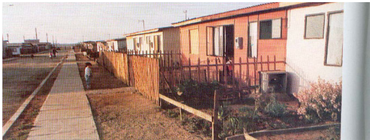
Conjunto habitacional Tierras Blancas, Coquimbo, IV Región.
