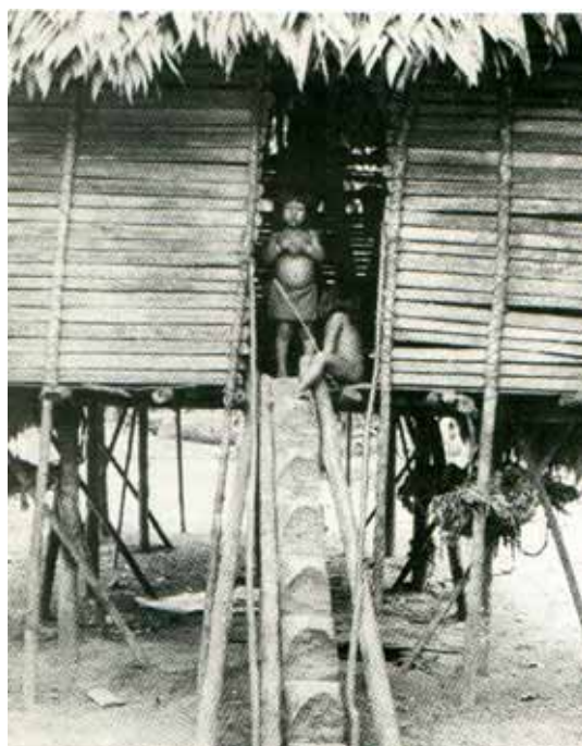
Figura 71 – CASA PALAFÍTICA NIPUKU COM PAREDES DE PAXIÚBA E ESCADA IÚRA
