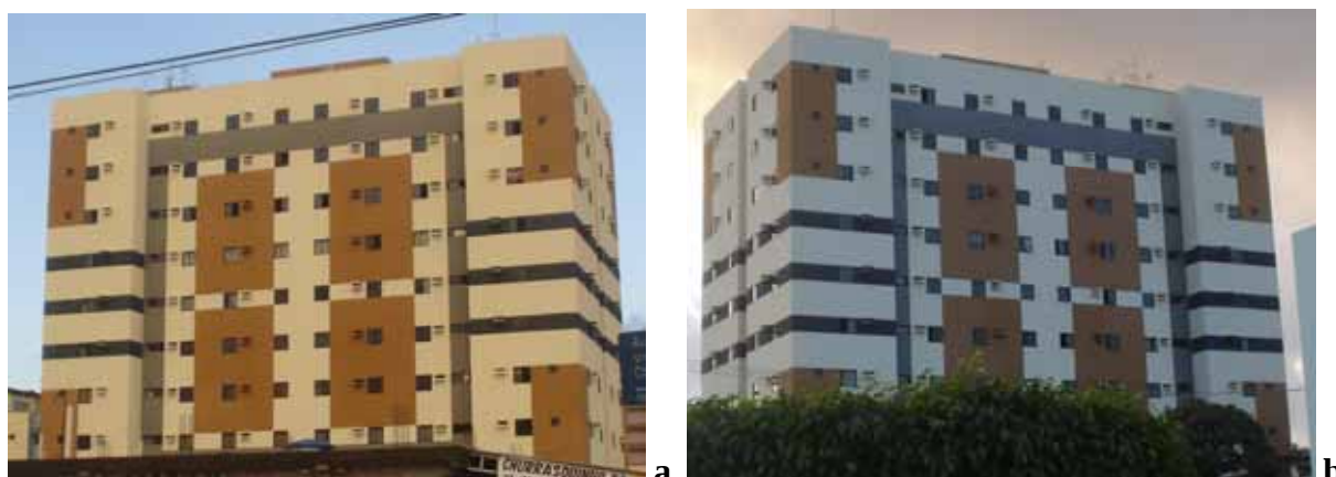
a-b- As fachadas laterais leste e oeste repetem-se integralmente. Janelas de alumínio com folhas corredeiras repetem-se em todos os lados. Talvez tal medida seja satisfatória do ponto de vista econômico ou estético. Mas certamente não é o ideal do ponto de vista do conforto térmico das unidades residenciais
