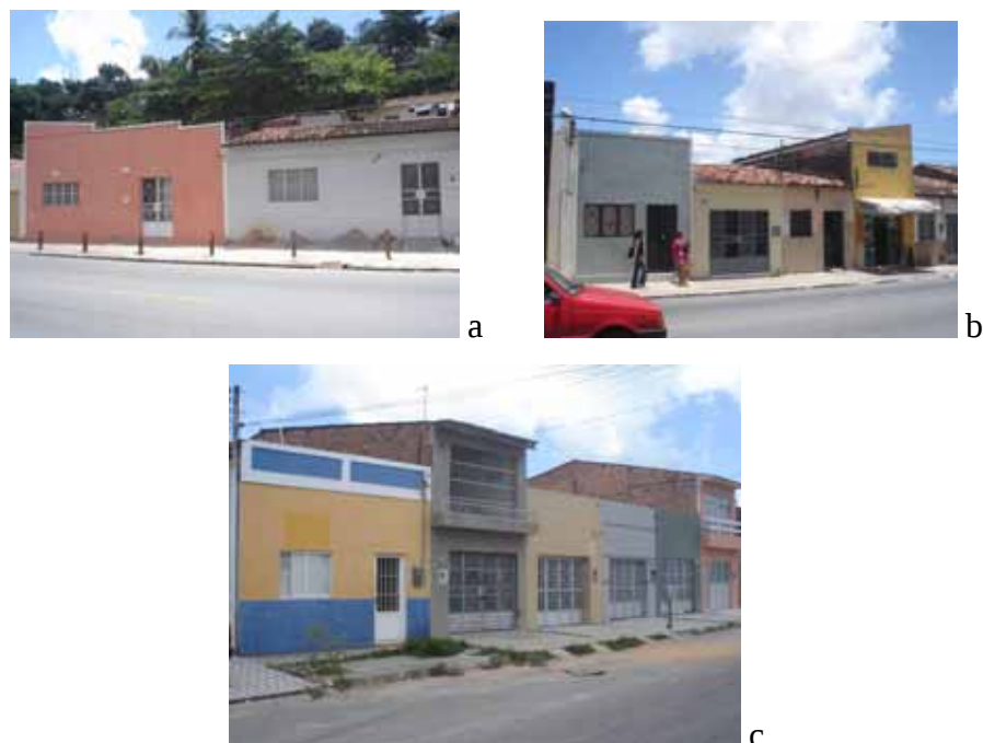
a- Casas na Cambona – Fachada Oeste; b- Casas na Cambona – Fachada Leste. c- Casas em Jaraquá.
