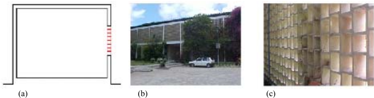
Figura 21: Corte esquemático (a) e exemplo de elemento vazado no Prédio de Física da UFAL, vista externa (b) e vista interna (c). Fonte: Arquivo pessoal da autora
