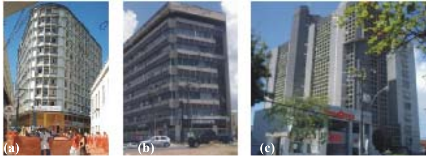
Figura 53: Fachadas com proteção solar, respectivamente: Edf. Breda Center (a), Edf. Emp. Ruy Palmeira (b) e Edf. Work Center (c).
