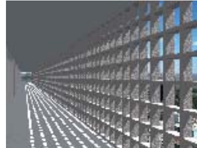
Figura 80: Cobogó de concreto
