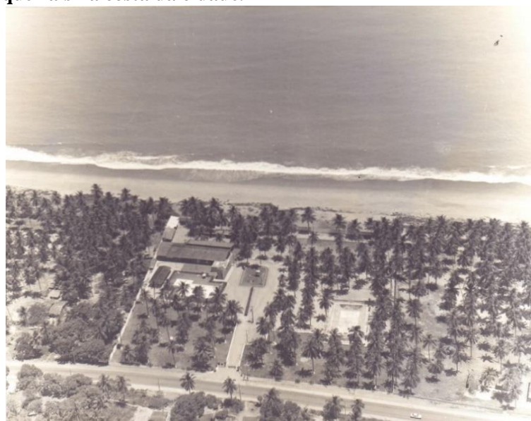
Figura 58 – Os coqueirais na costa da cidade.
