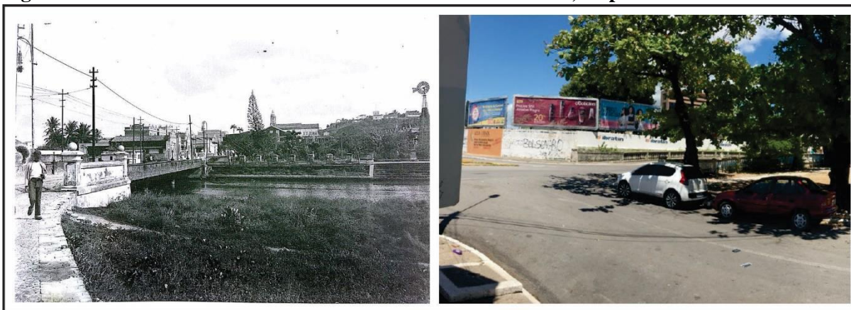
Figura 37 - Ponte dos Fonseca: no início do século XX e em 2018, respectivamente.
