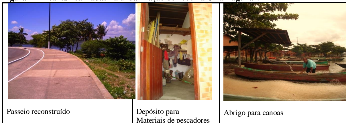
Figura 122 - obras realizadas na urbanização de 2000 na Orla Lagunar.
