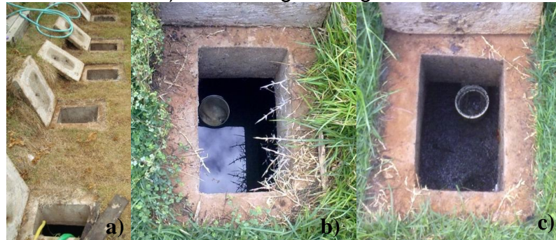
Figura 20 - Sistema estudado: a) Visita das câmaras; b) Entrada águas cinzas; c) Entrada águas negras.
