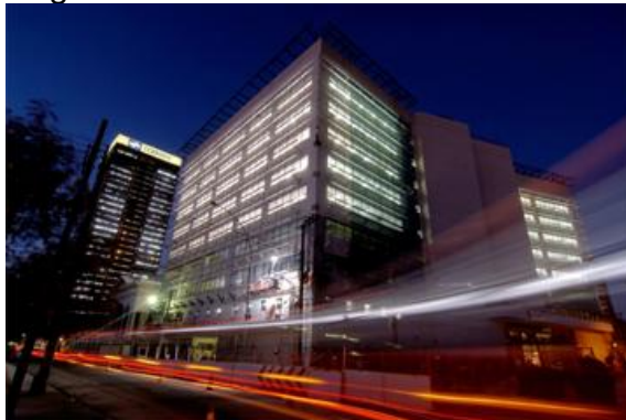
Figura 06 - Edifício Cidade Nova – RJ.
