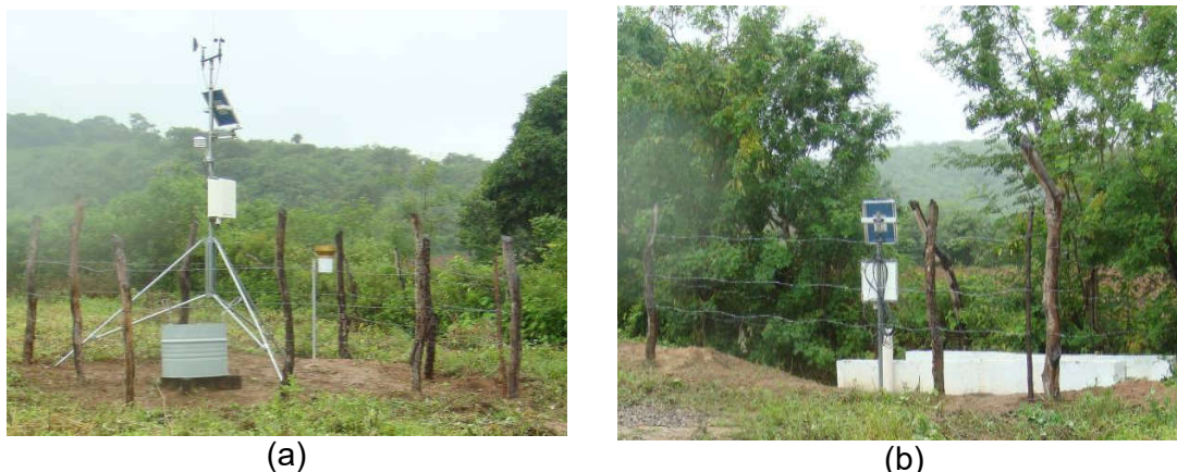
Figura 32 – (a) Estação Climatológica e (b) Calha Parshall
