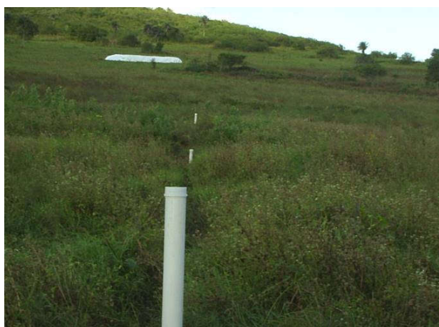
Figura 47 – Piezômetros instalados na BESI
