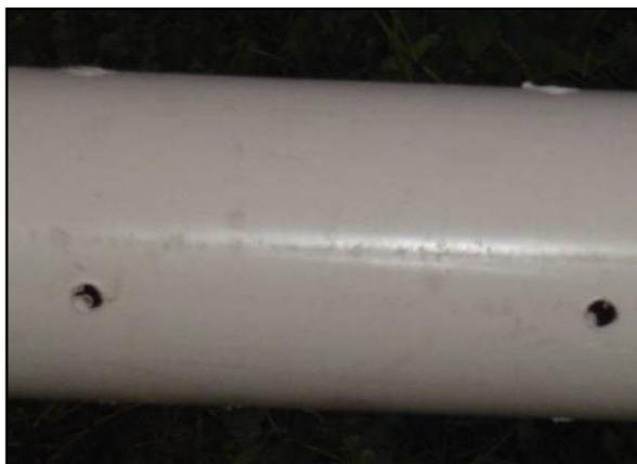
Figura 25: Furos, realizados nos tubos, para a execução dos piezômetros
