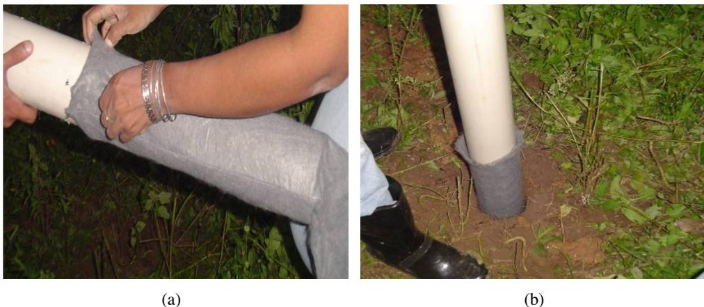
Figura 26: (a) Revestimento com geotêxtil e (b) Cravação dos tubos dos piezômetros
