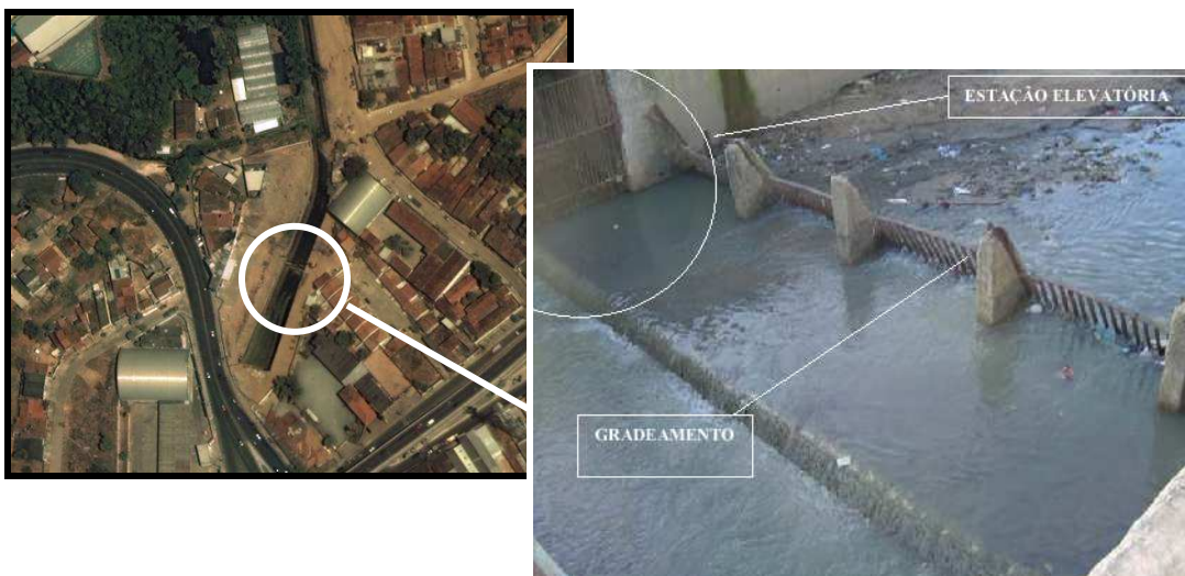
Figura 3.17 – Elevatória localizada no curso d'água principal
