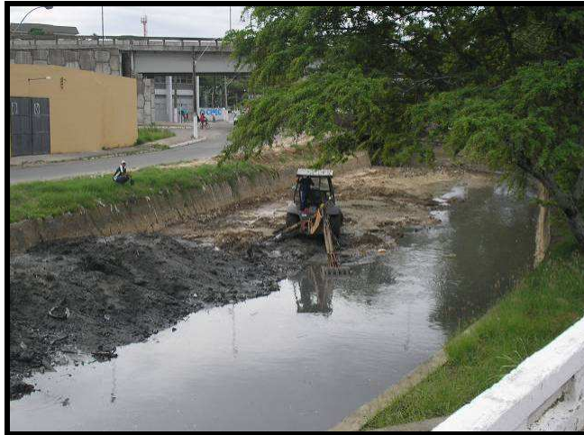
Figura 3.12 - Retirada de sedimentos do canal
