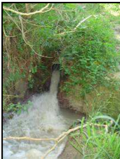
Figura 3.15 - Esgoto despejado na rede de águas pluviais que chega até o riacho
