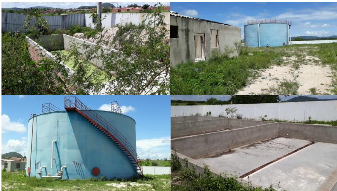
Figura 7: Imagens do tratamento de esgoto do Município de São José da Tapera- AL
