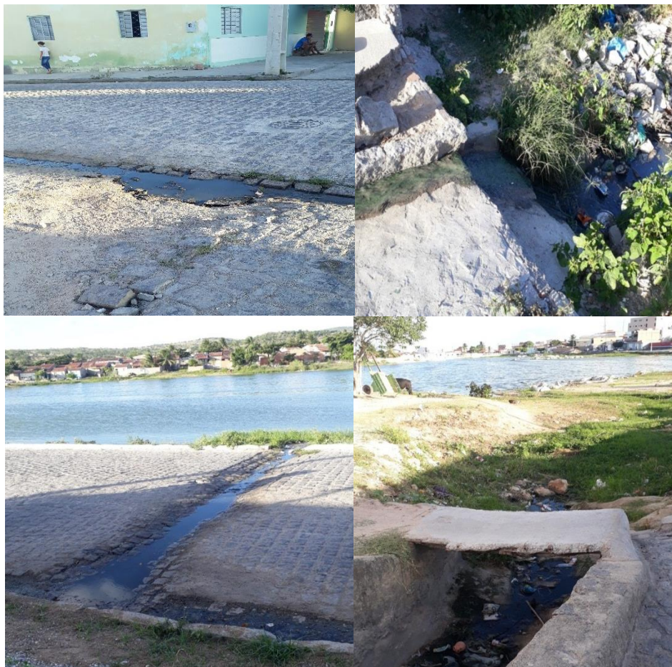
Figura 6- Ruas do município de São José da Tapera- Al sem drenagem pluvial
