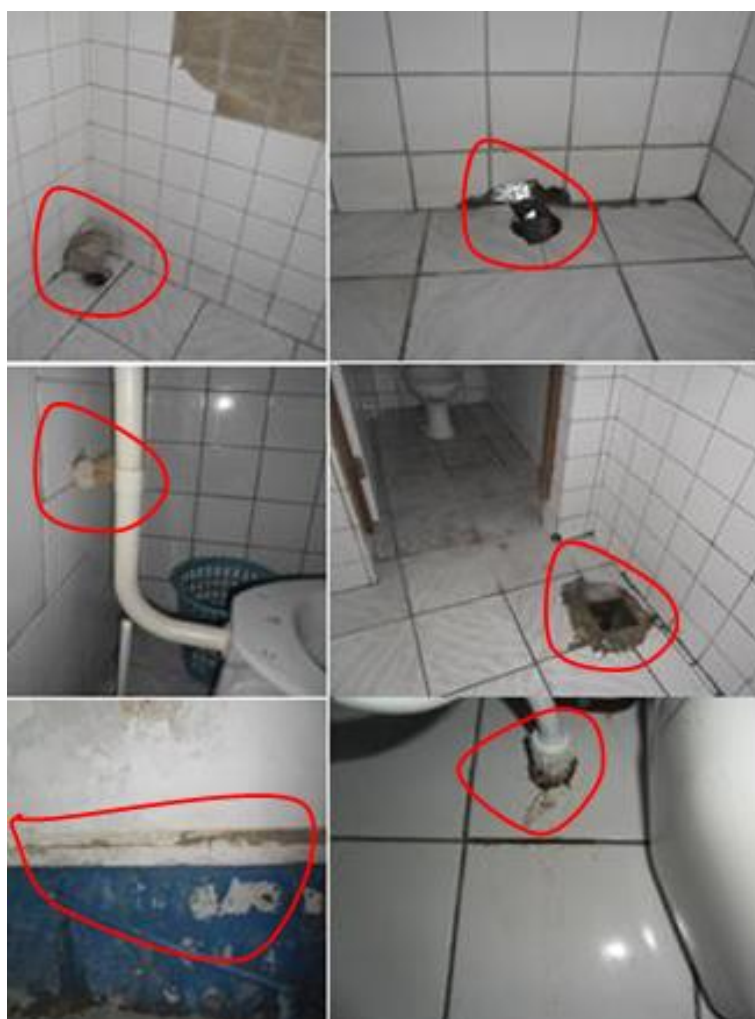
Figura 11: Banheiro da escola “A”
