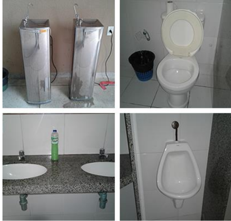
Figura 4.1 – Levantamento de dispositivos sanitários na universidade.
