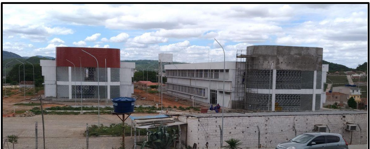
Figura 8 - foto da 1ª ETAPA DA SEDE DA UNIDADE EDUCACIONAL SANTANA DO IPANEMA. À esquerda Bloco 1 e a direita Bloco 2
