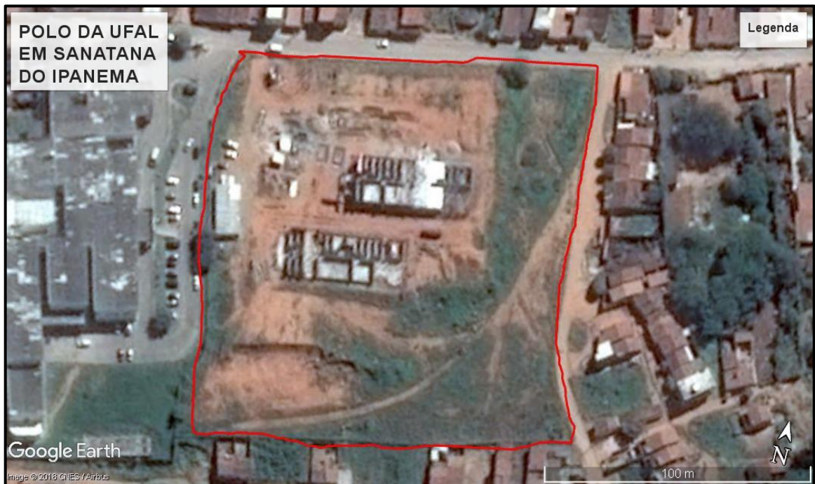
Figura 7 - Imagem aérea da construção da 1ª ETAPA DA SEDE DA UNIDADE EDUCACIONAL SANTANA DO IPANEMA. Área total do terreno contornada de vermelho
