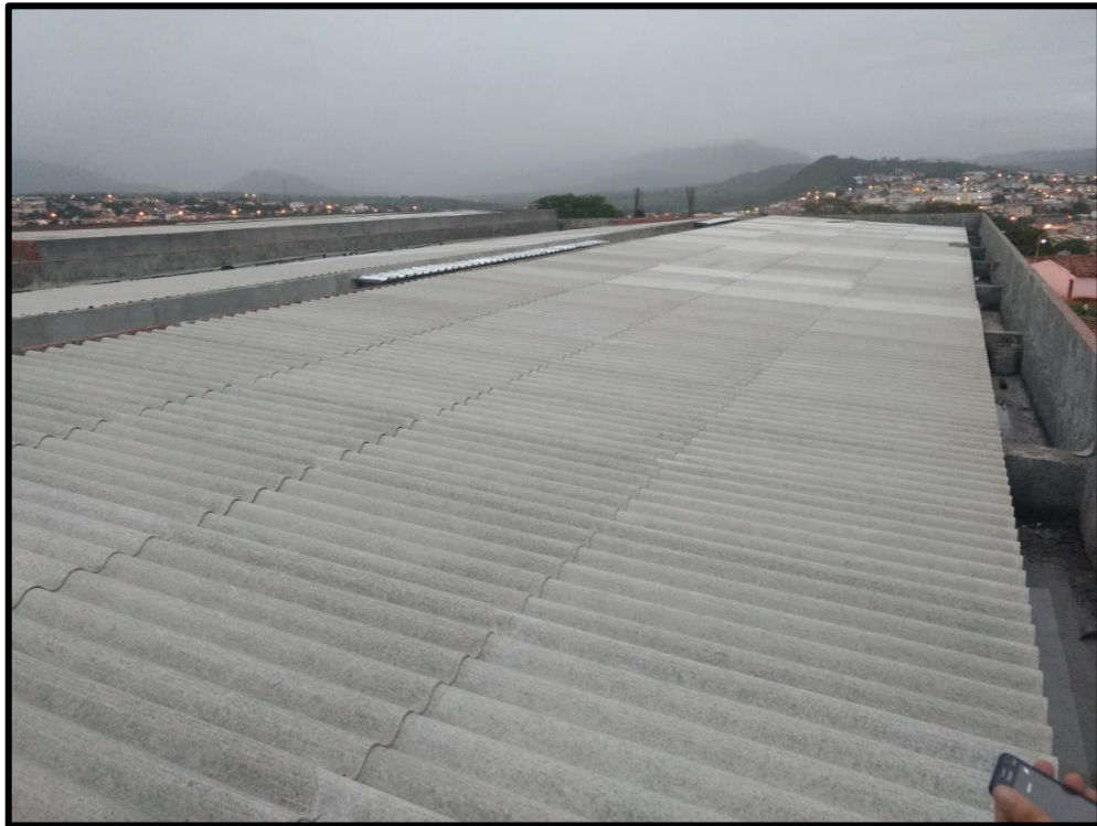
Figura 9 - foto da coberta com telha de fibrocimento do tipo ondulada do Bloco 2 da 1ª ETAPA DA SEDE DA UNIDADE EDUCACIONAL SANTANA DO IPANEMA.
