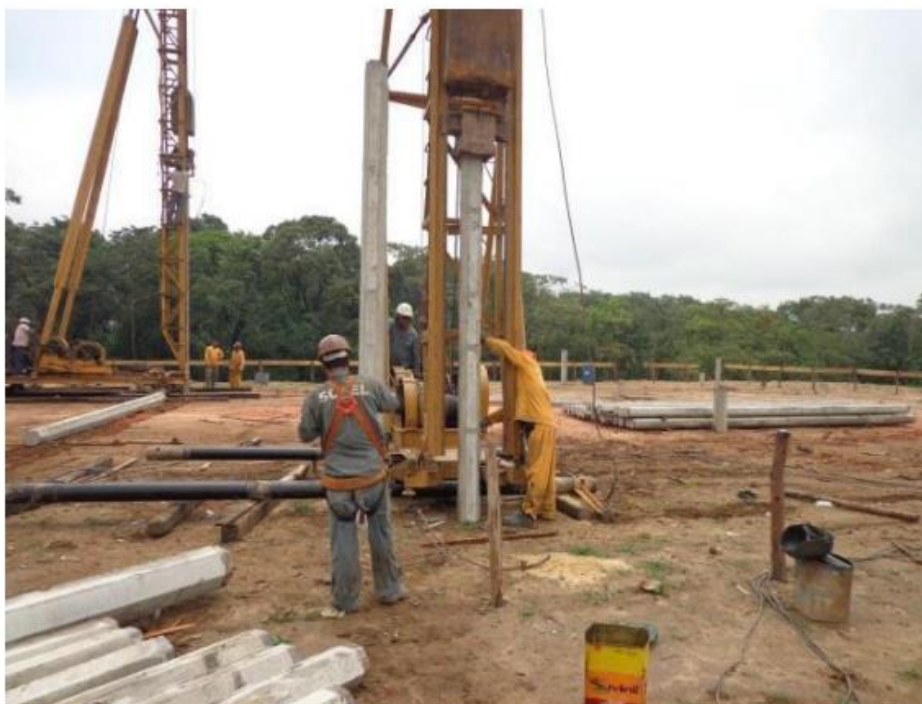
Figura 4. Estaca sendo cravada no terreno
