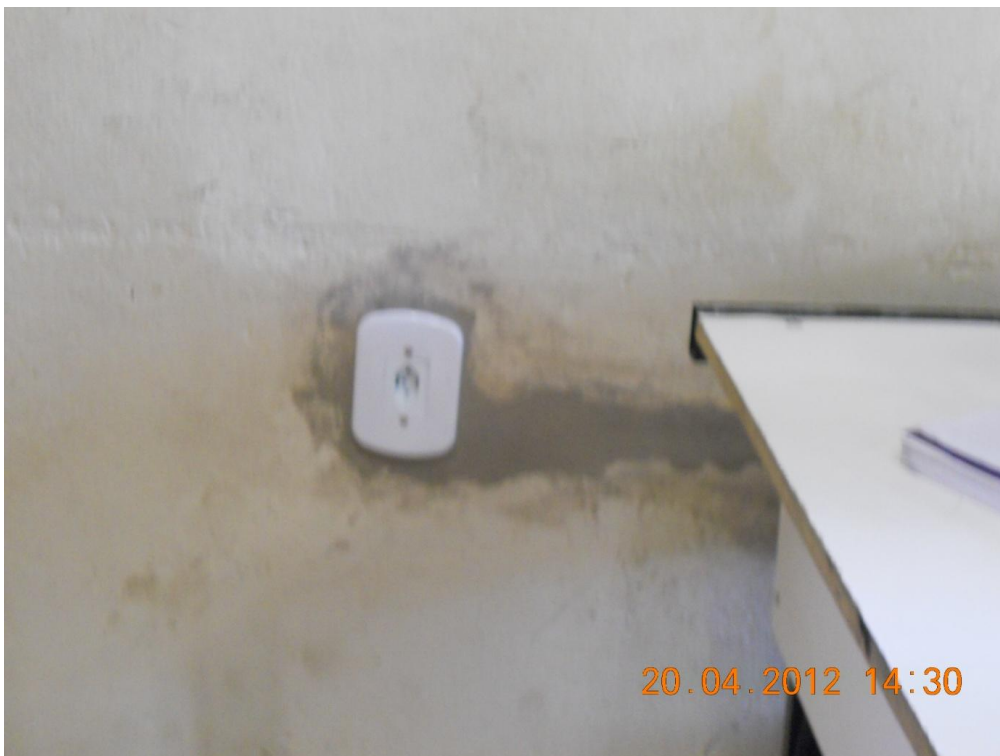
Novas tomadas para uso do laptop após retirada das tomadas antigas nas bancadas
