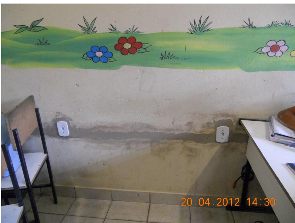
Instalação das novas tomadas após retirada das tomadas nas bancadas
