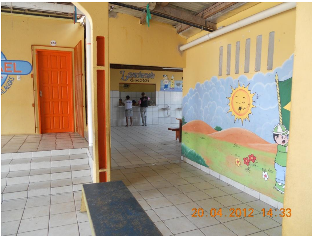
Vista para cantina após reforma
