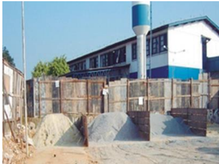
Figura 3: Acondicionamento inicial de agregados a granel em baias.
