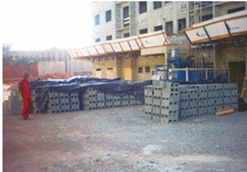
Figura 5: Empilhamento de blocos de concreto.
