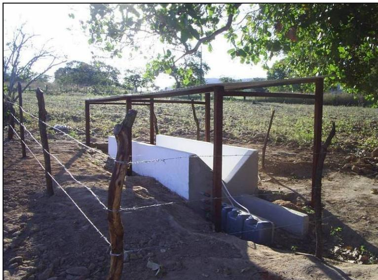
Figura 18 – Fossa de sedimentos instalada no exutório da microbacia.
