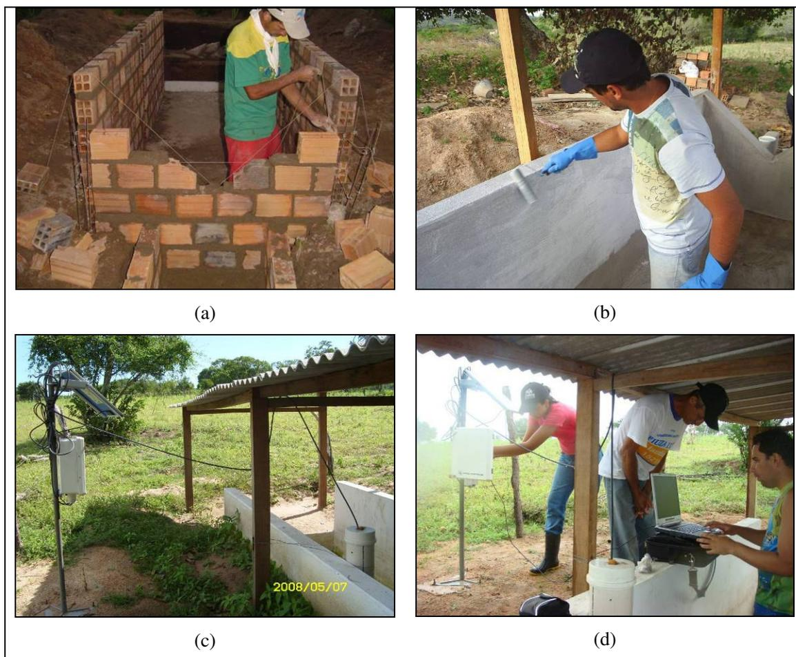
Figura 17 – Etapas da construção, instrumentação e coleta de dados na fossa de sedimentos: (a) Construção do vertedor; (b) Pintura das paredes; (c) Configuração utilizada na instalação do linígrafo; e (d) Coleta de dados do linígrafo.
