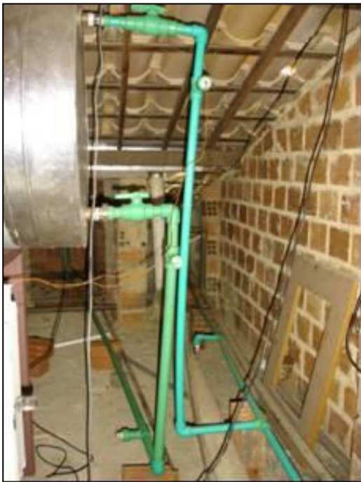
Figuras 39 e 40 – Vista das posições das tubulações hidráulicas de entrada e saída de água do reservatório térmico
