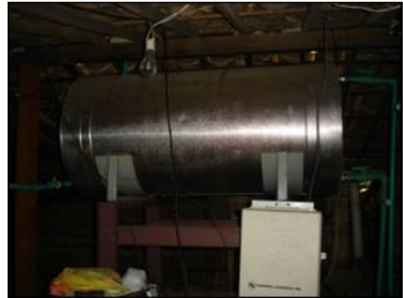
Figuras 37 e 38 – Vista do reservatório térmico montado em residência unifamiliar
