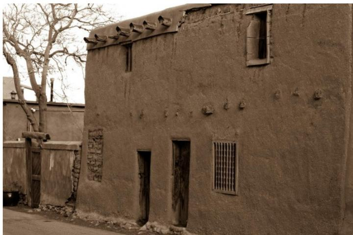
Ilustração 4 - Casa construída no ano de 1540: adobe reforçado com palha (IMAGEM, 2009).
