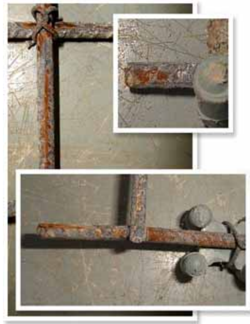
Figura 41 – Corrosão nas armaduras de argamassas com sílica aos 180 de exposição.
