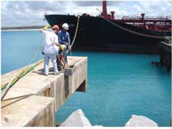
Figura 24 – Descendo uma das caixas.
